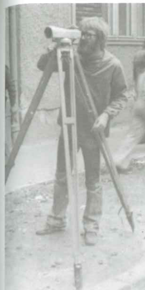
Szabatos szintezés Ni A1 műszerrel
