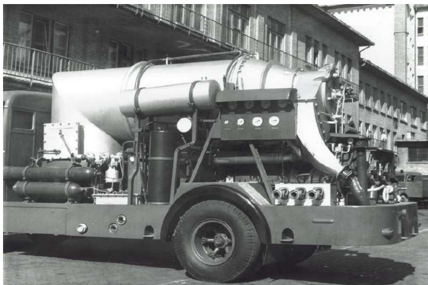
1. kép: Szilvay Kornél által tervezett szárazoltógép, [1]
