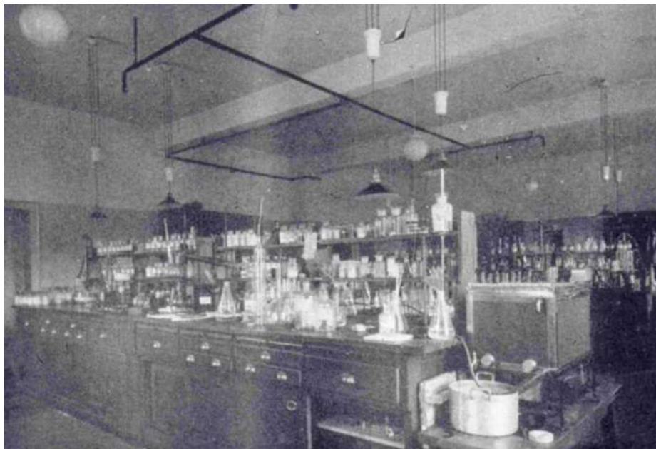
8. ábra: Olvadórózsákkal ellátott oltórendszer elhelyezése vegyi laboratóriumban [18]
