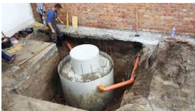
25.számú ábra Föld alá telepített zsírfogó [24]
