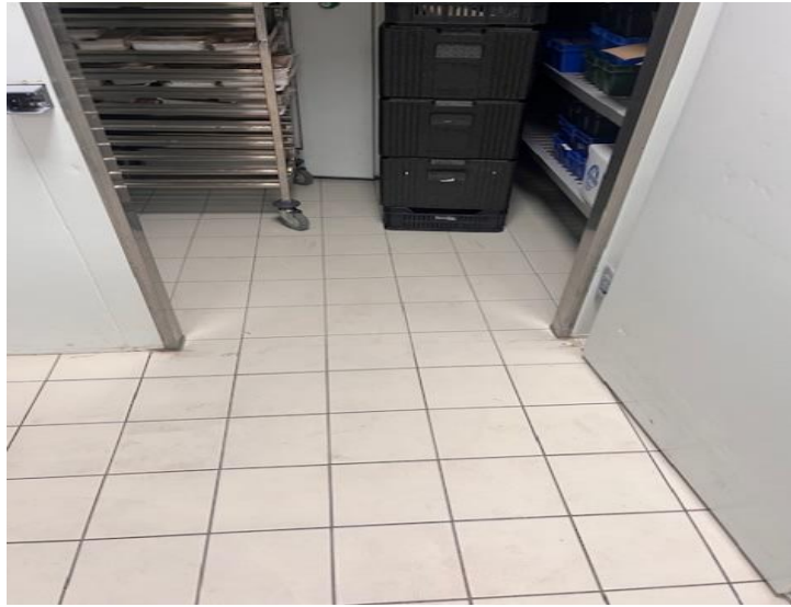
14.számú ábra Hűtőkamra és a folyosó padlója egy szintben [28]
