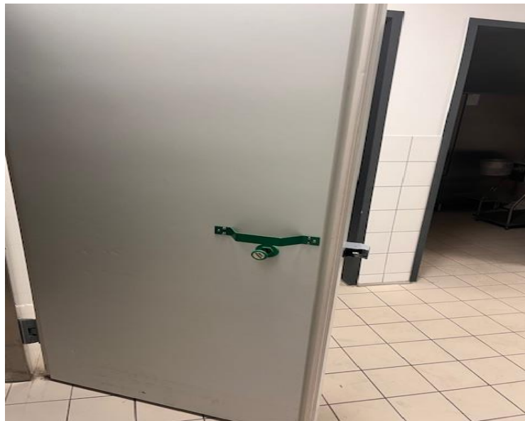
15.számú ábra Hűtőkamra belülről nyitható, foszforeszkáló jelölés [28]
