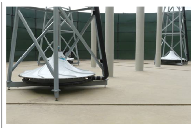
2. kép: SBR reaktor keverői
