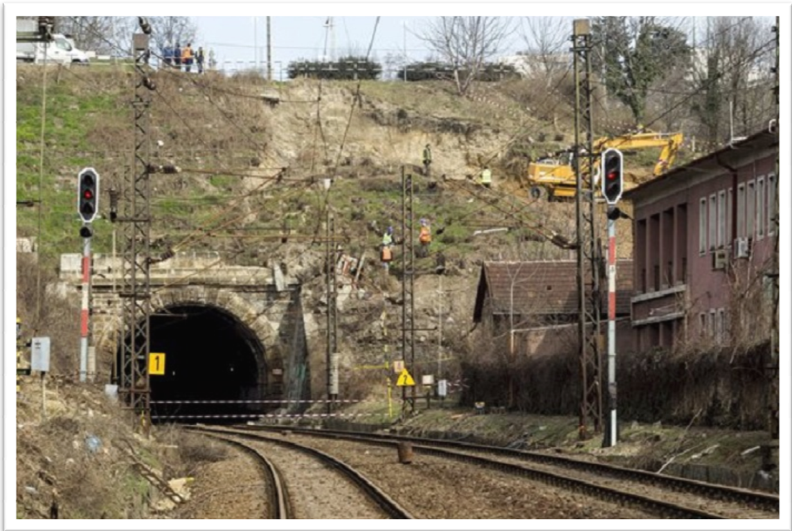
7. kép: Déli pályaudvari rézsúcsúszás
