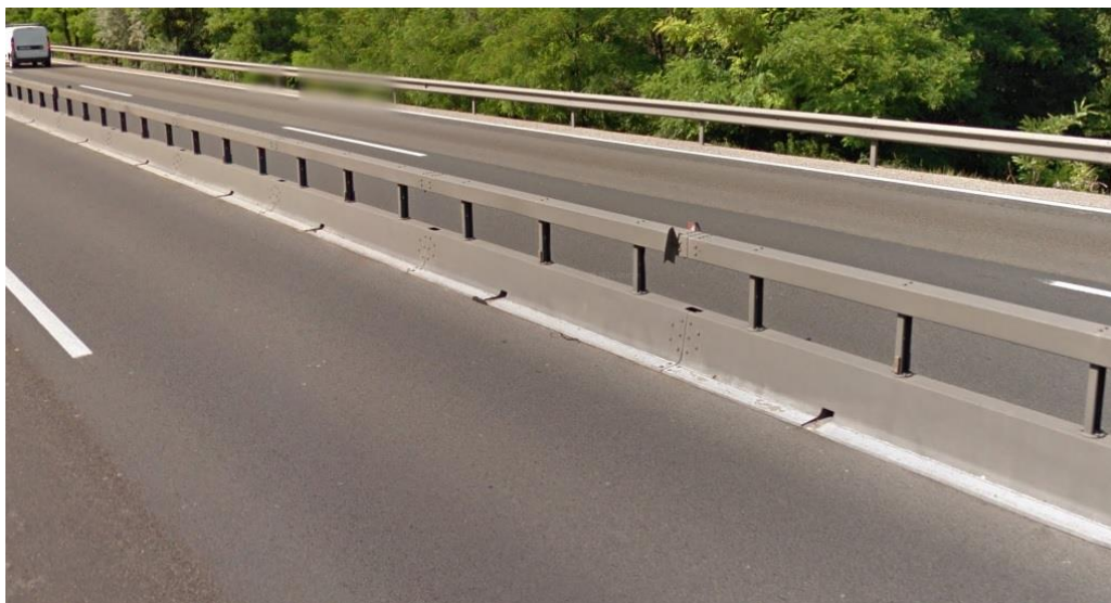
5. ábra VARIO-GUARD acél korlárendszer az M0-án 2014-ben (forrás: maps.google.com )
