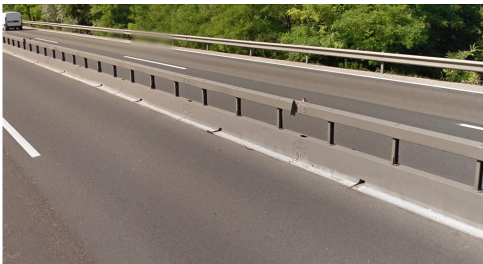
33. ábra VARIO-GUARD korlátrendszer az M0-áson 2014-ben (forrás: maps.google.com)
