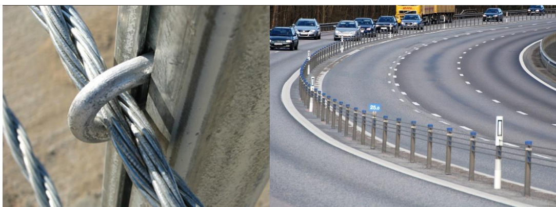
1. ábra Acélkábel korlát Svédországban (forrás: baloldal: gibraltartx.com, jobb oldal: baltris.eu)
