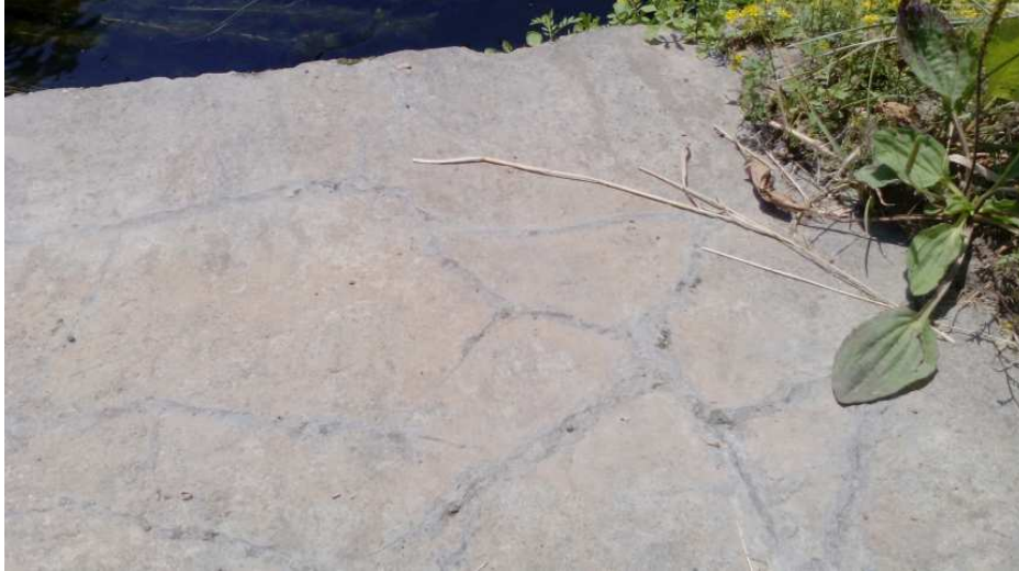
9.6. ábra:repedések a betonburkolaton
