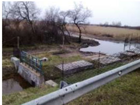
31. kép: Olajfogó műtárgy
