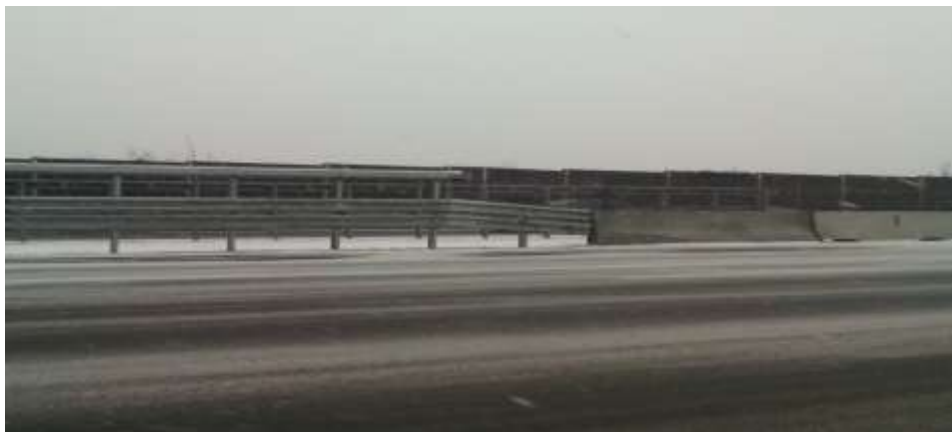
64. kép: DAK H3-as korlát csatlakozása betonelemmel
