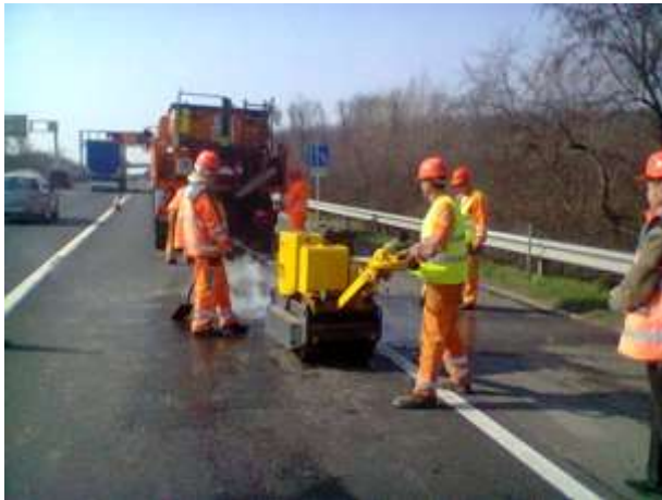
49. kép: Aszfalt bedolgozás kishengerrel
