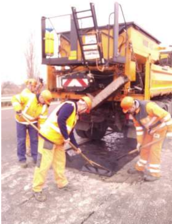
67. a. kép: Kézi bedolgozás
