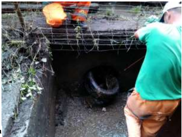
26. kép: Eltömődött áteresz takarítása
