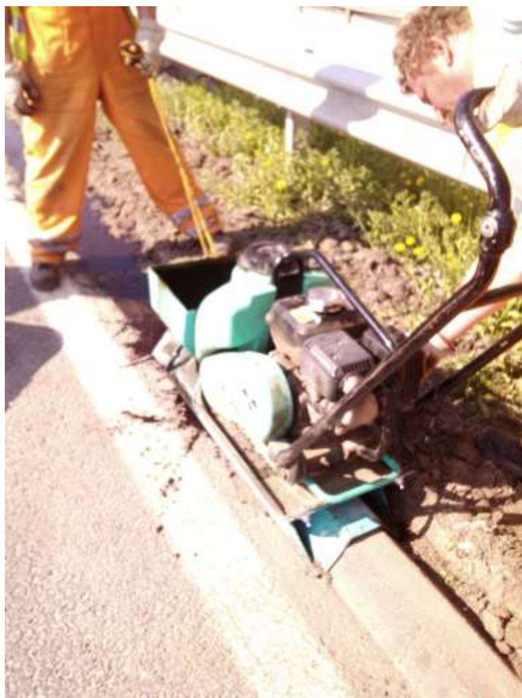
68 b. kép: aszfalt kiemelt szegély építése
