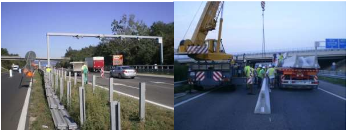
47. a-b. kép: Beton terelőfal építése
