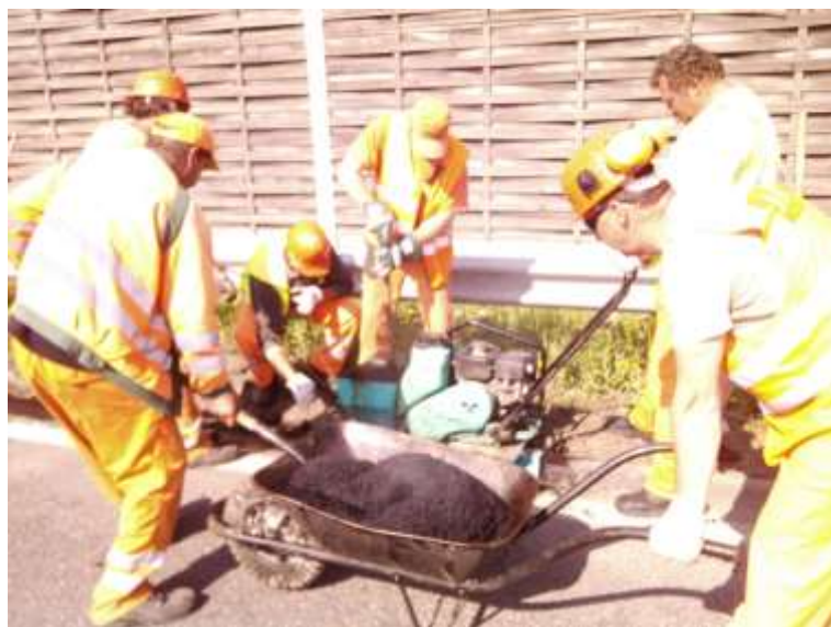
68 a. kép: aszfalt kiemelt szegély építése
