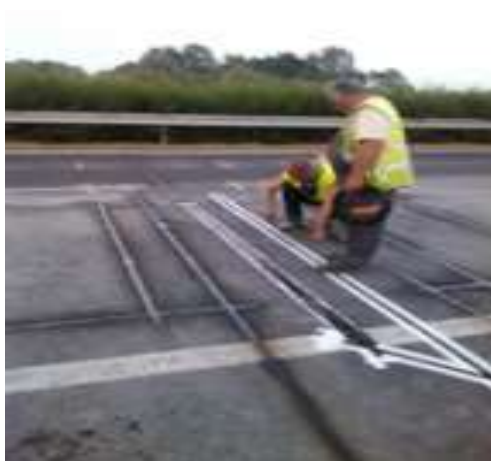
15. kép: Induktív hurokdetektor beépítése működése
