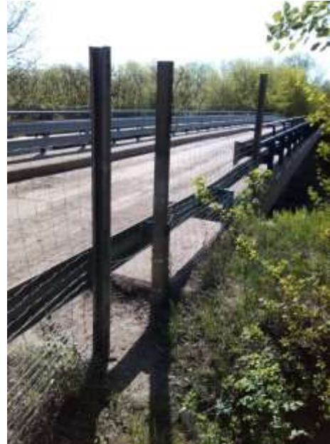
57. kép: Rákötés kiépítése keresztező műtárgyra
