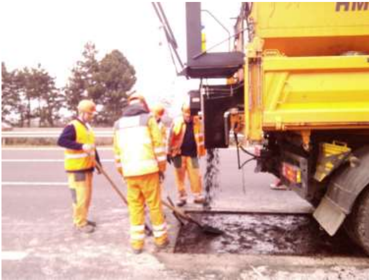
67. a. kép: Kézi bedolgozás
