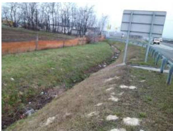
60. kép: Kerítésre szerelt mobil hóvédmű
