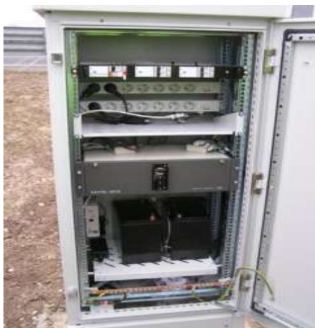
13. kép: Forgalomszámláló berendezés „agya”
