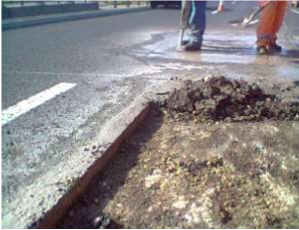
48. kép: Hagyományos kézi bontás
