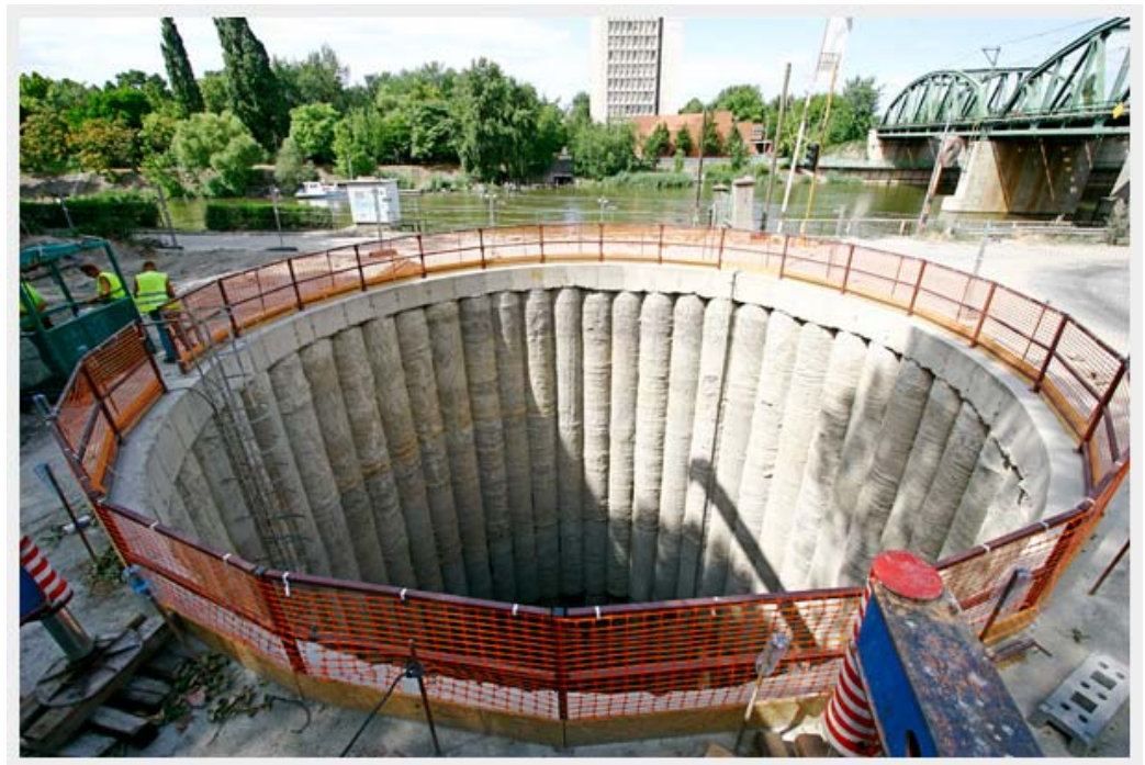
9. ábra Vízáró cölöpfal
