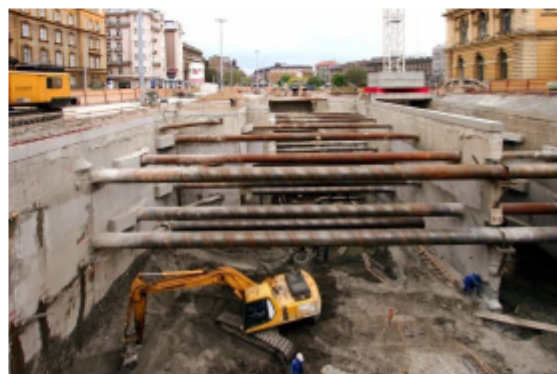
13. ábra Belső csőtámaszos résfal megtámasztás
