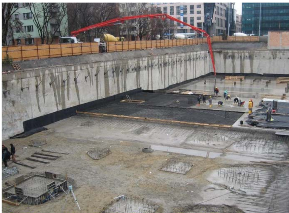
12. ábra Horgonyzott résfal
