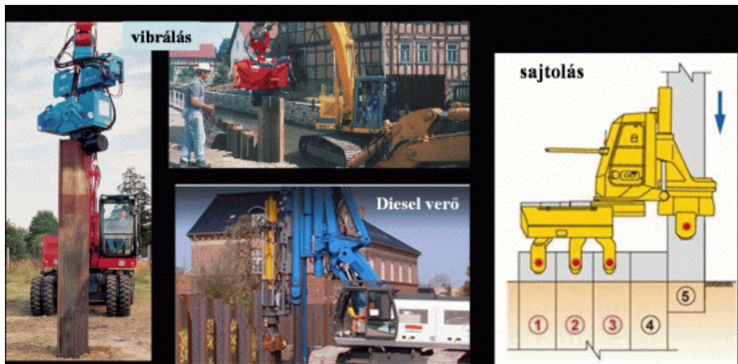
7. ábra Szádfal lehajtási technológiák
