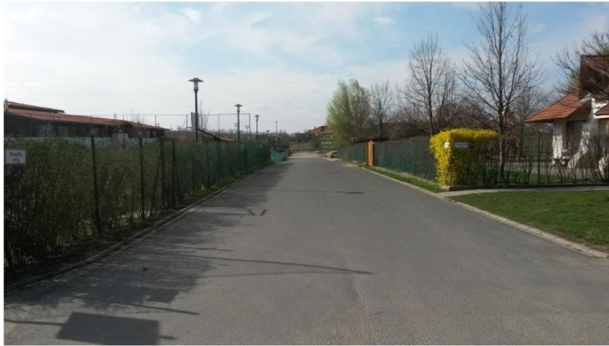
7. sz. kép: Nagy burkolt felület komolyabb csapadékvíz-elvezetés nélkül
