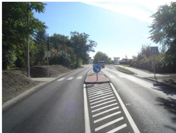
14. sz. kép: Budajenői úti gyalogátkelőhely
