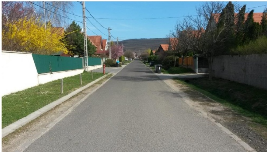
2. sz. kép: Lakóútca aszfalt burkolattal, nyílt árokkal
