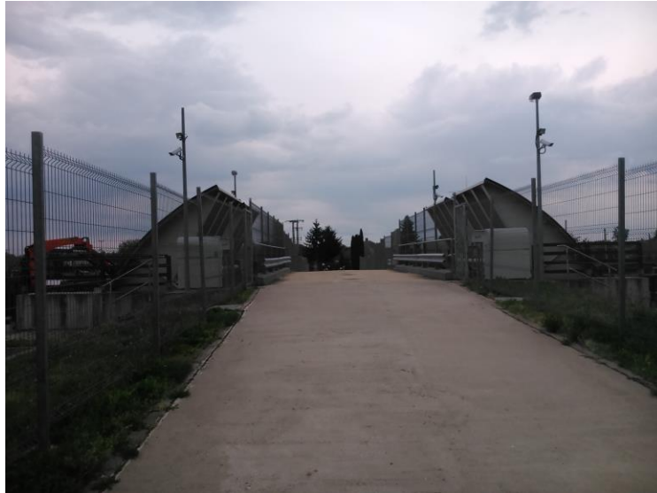
7.ábra Üzemi átjáróhíd
