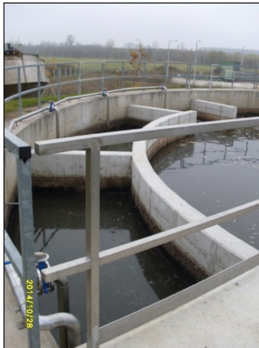
4. kép Szelektortér
