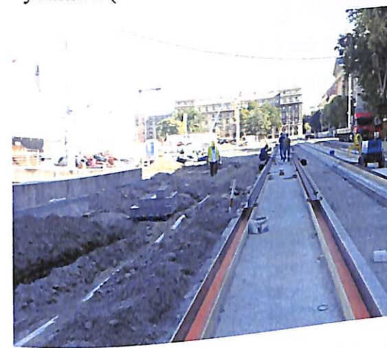
44. ábra. A 2-es villamos pályájának áthelyezési munkái
