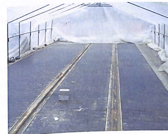
45. ábra. A 2-es villamos pályájának áthelyezési munkái -5 Celsius fok alatt
