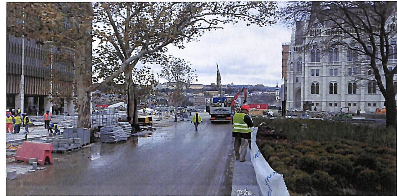
58. ábra. Térburkolási és kertépítészeti munkák
