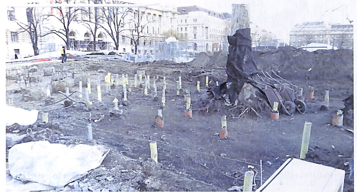
59. ábra. Kossuth szoborcsoport posztamentének alapzat kitűzése
