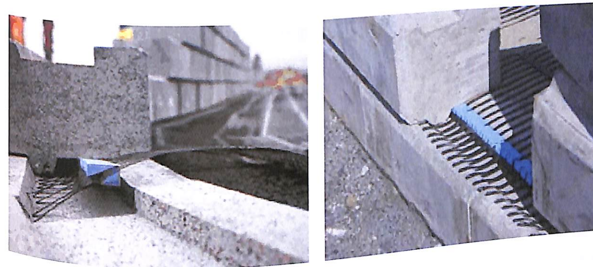
9.4. kép: TW1 elemek és a georácsok összekapcsolása
