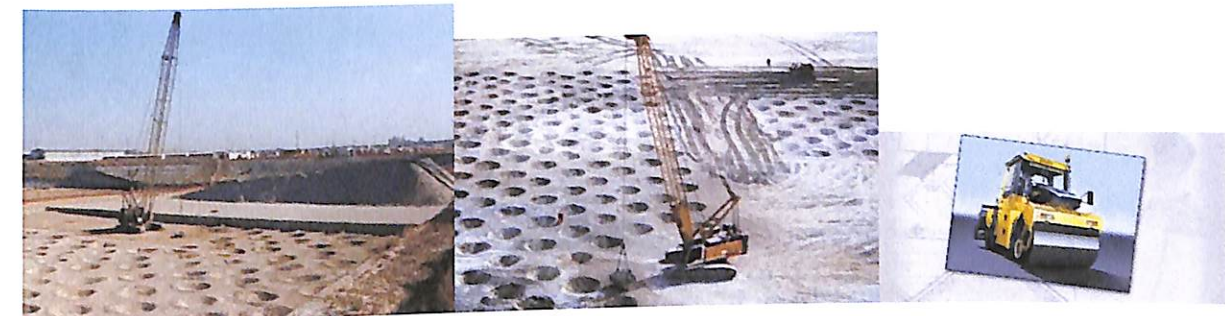
1.1 kép: Felszíni döngölés 1.2. kép: Dinamikus talajtömörítés 1.3. kép: Statikus henger
