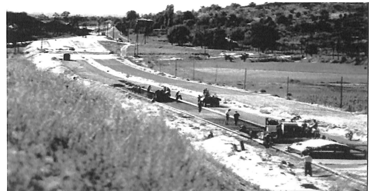
M1 – M7 bevezető szakaszának építése Vögele finiszerrel
