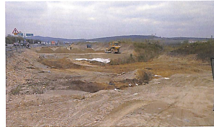
Altalaj cseréje, építése
