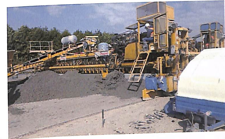
Betonozó géplánc ábra
