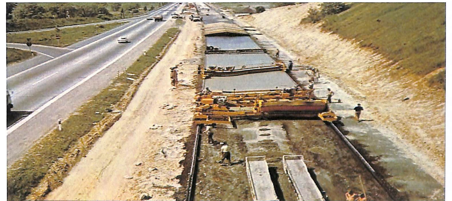
M7 betonozása formasínek között 1973-ban
