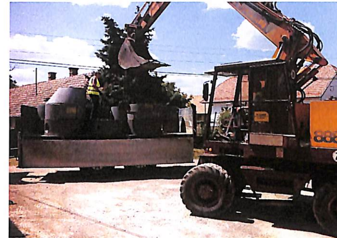
8. ábra Aknaelemek érkezése
