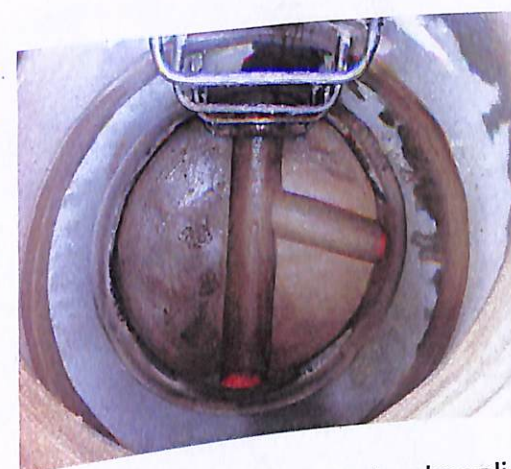
69. ábra Kamerázásra alkalmas tiszta aknaalj
