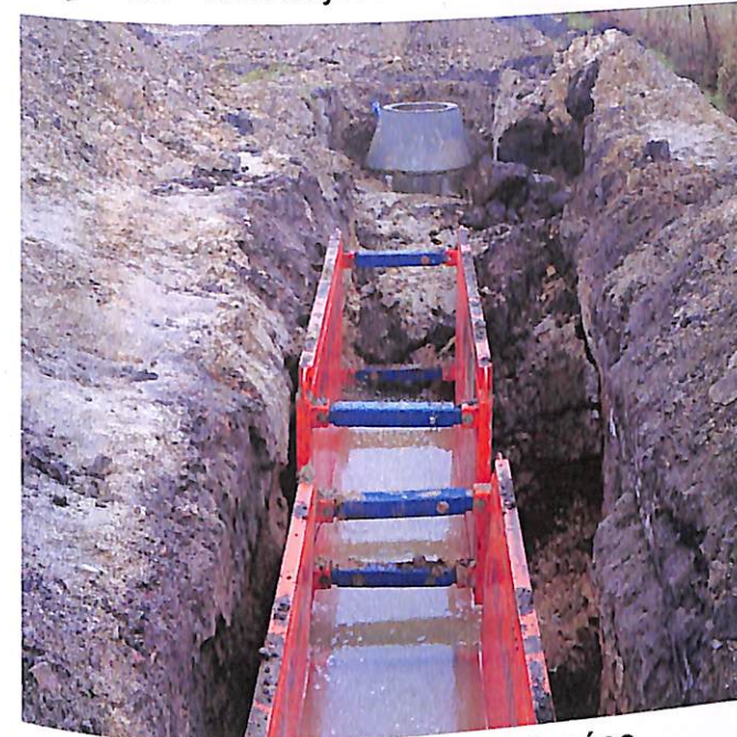
55. ábra Talajvíz megjelenése
