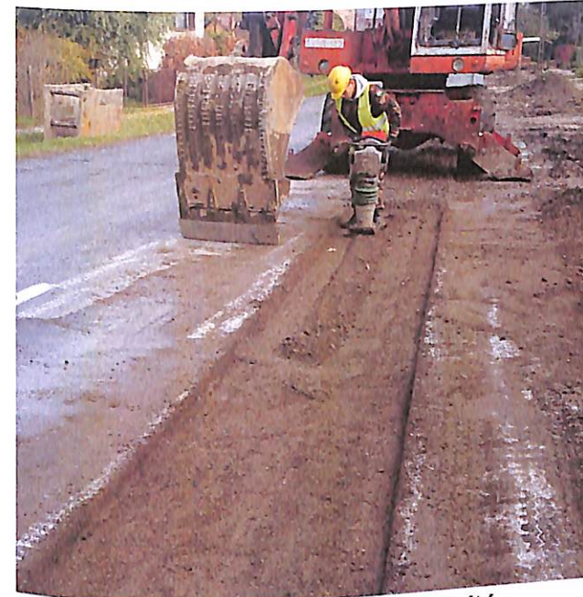
44. ábra Rétegenkénti tömörítés
