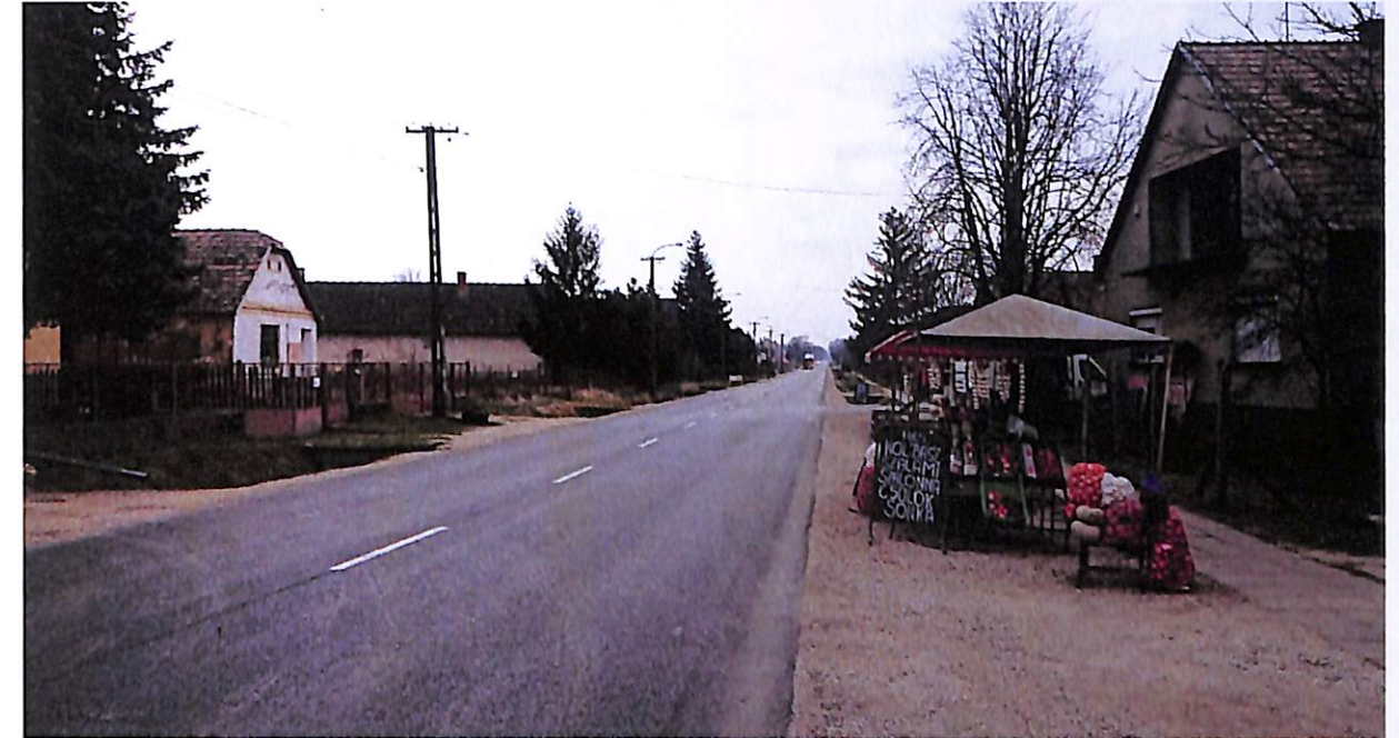
88. ábra Aszfaltozás, padka felújítás
