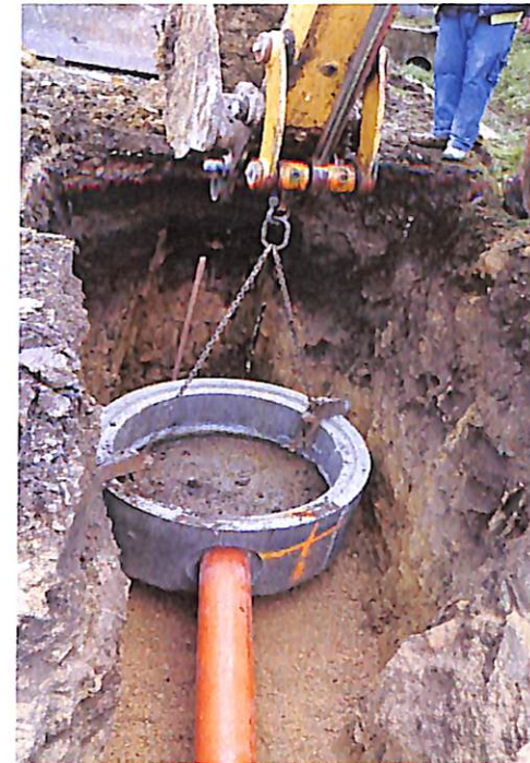
31. ábra Tisztítóakna-alj telepítése
