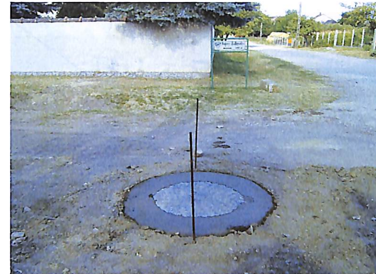
41. ábra Aknagallér betonozása
