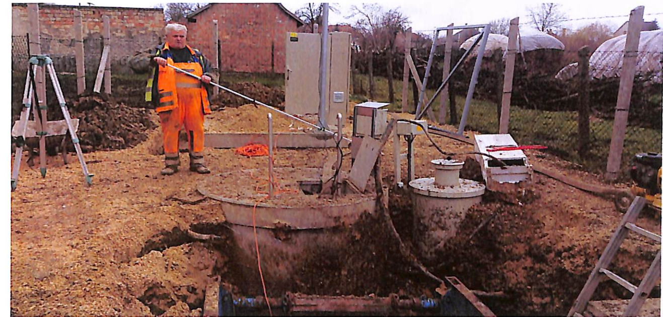
60. ábra Átemelő építés alatt
