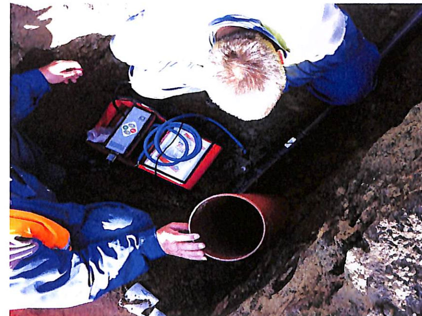
42. ábra Nyomóvezeték sűtése
