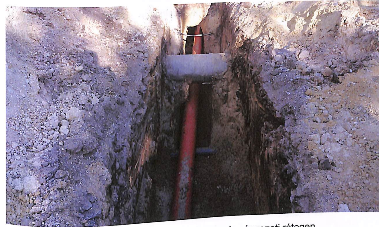
36. ábra Csővezeték, homokos-kavics ágyazati rétegen
