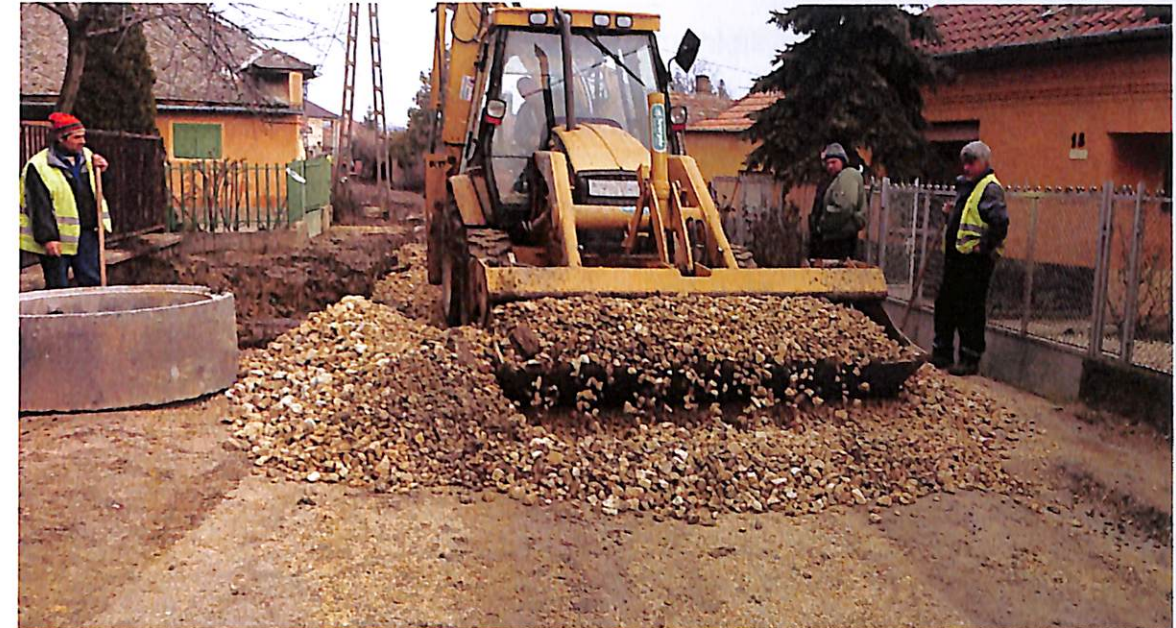
84. ábra Zúzottkő terítés
