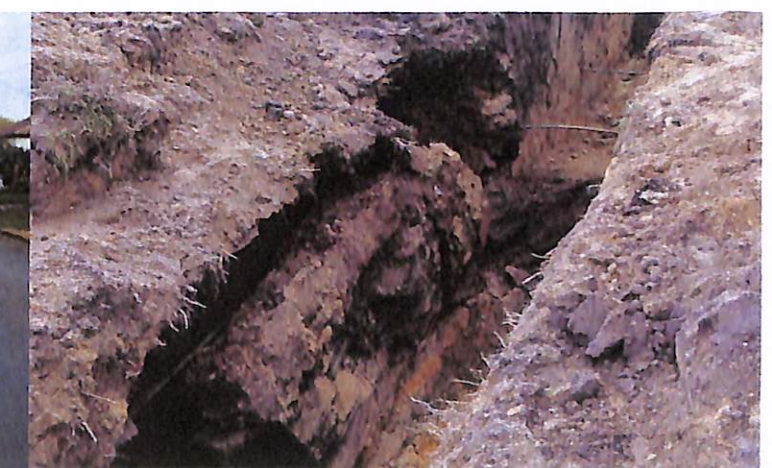
35. ábra Dúcolatlan munkaárok
