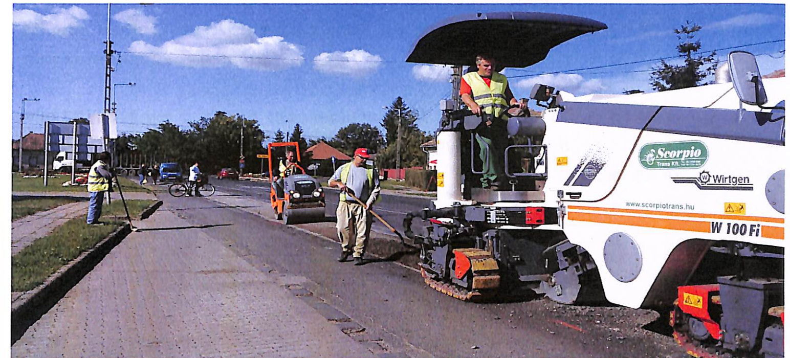
22. ábra Darált aszfalt hengerlése
