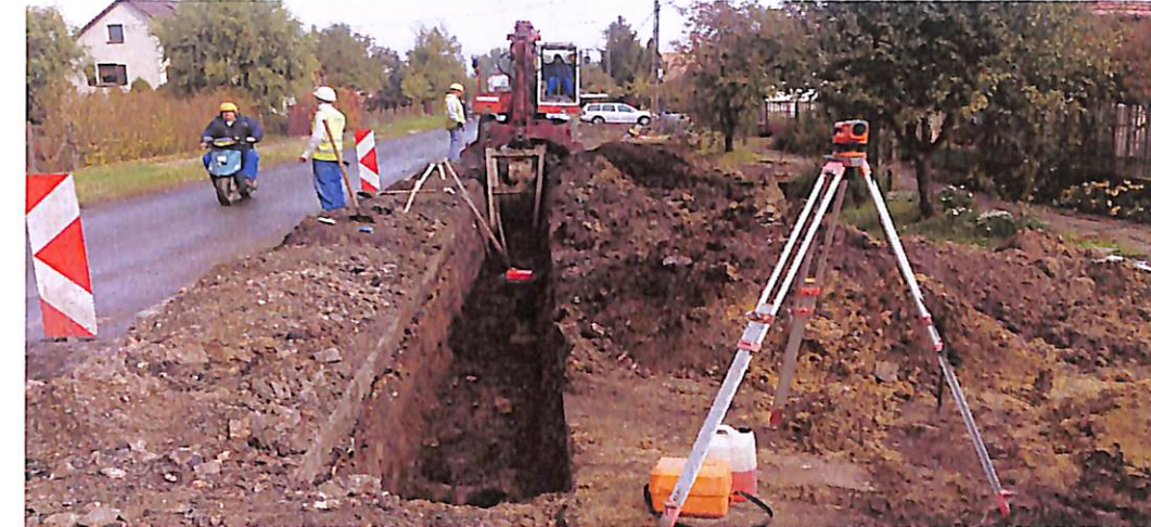
39. ábra Rétegenkénti tömörítés
