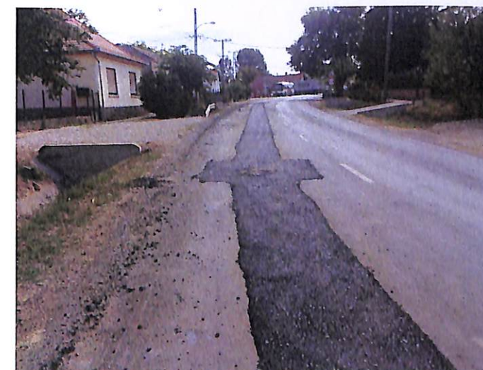
87. ábra Ideiglenes aszfaltozás
