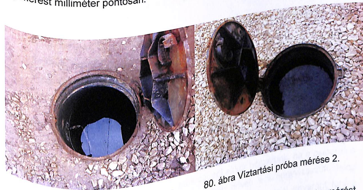
79. ábra Víz tartási próba mérése 1.
