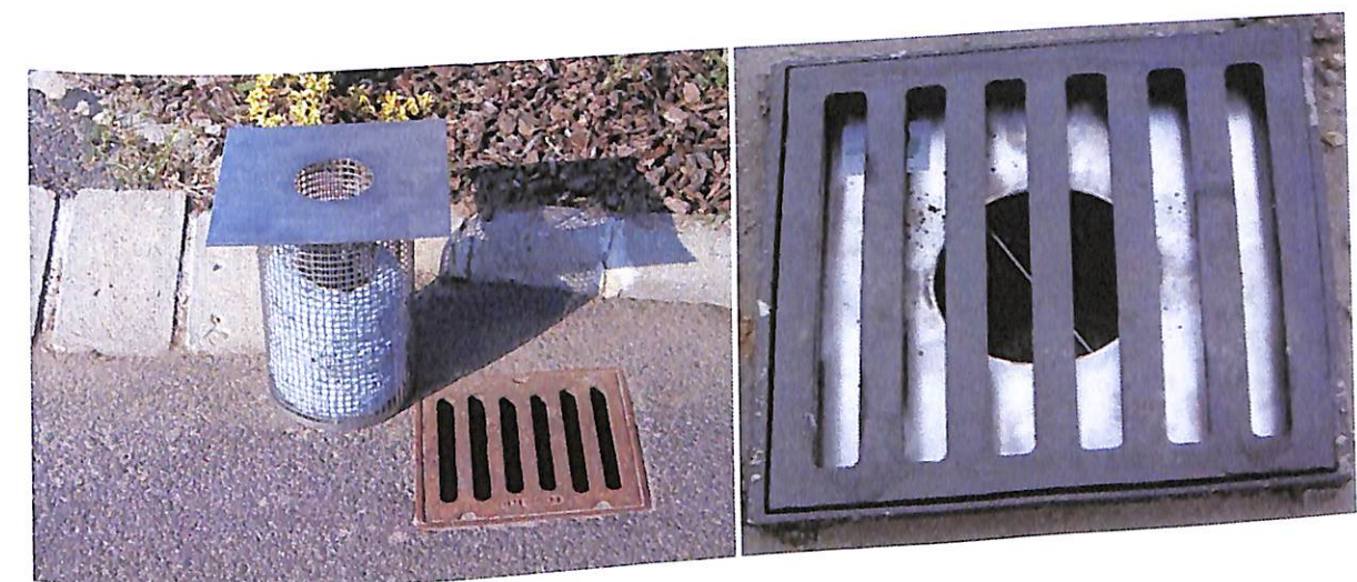
15. ábra: Bárczy-féle csapadék olajsűrő beépítés előtt (bal) és után (jobb) . [9]
