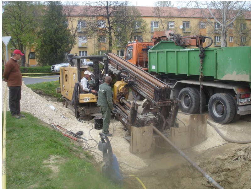
20.kép HDD berendezés telepítése
