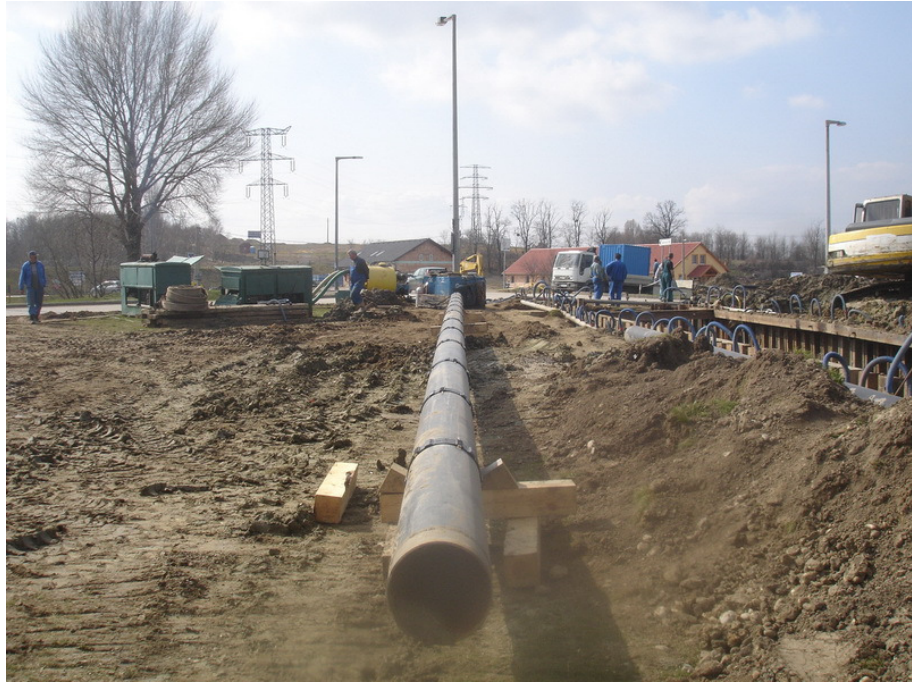
14.kép Védőcsőbe behúzásra előkészített csőszakasz, 2m-re szerelt távtartókkal Forrás: Szűcs László, 2011
