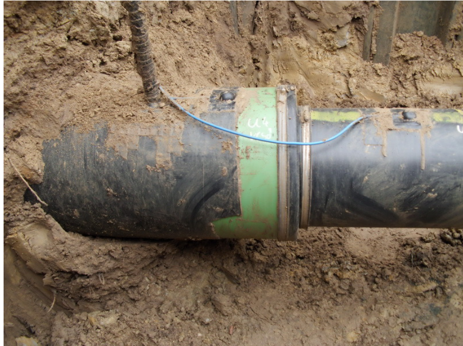
12.kép Gyűrűstér lezárása gumiharanggal Forrás: Szűcs László, 2010
