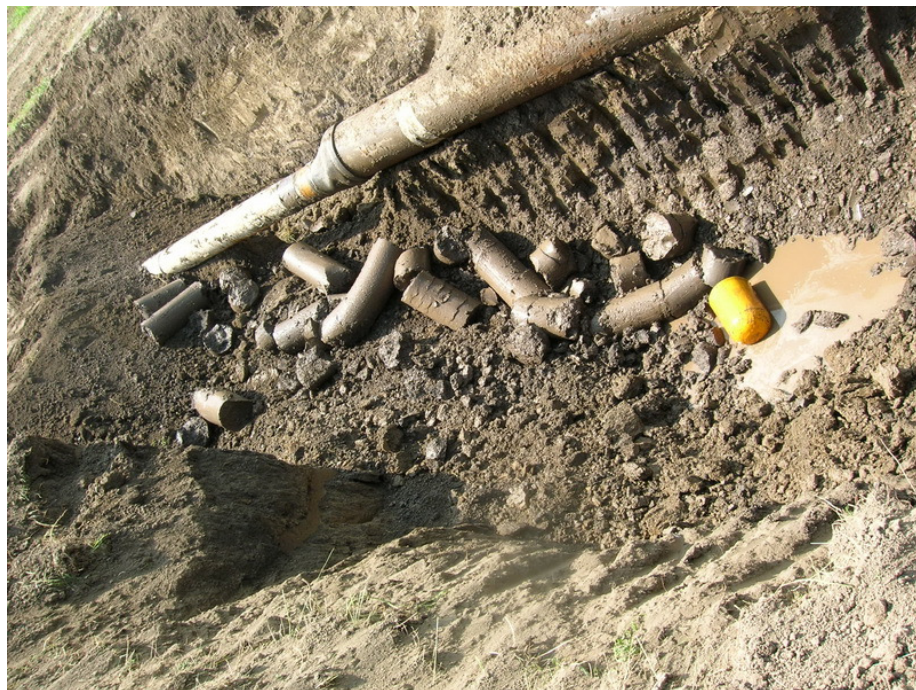
40.kép Fogadó árok földkinyomást követően – látható a kiváltandó védő – és termelőcső, az új csőből kivetődő földmag darabjai és a tisztításhoz használt habgörény Forrás: Szűcs László, 2007
