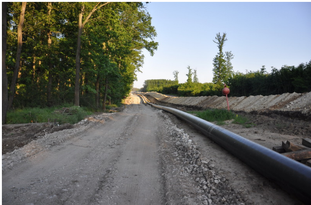
58.kép Ideiglenes bekötőút építése 2800m hosszan Forrás: Dénes Pál, 2014
