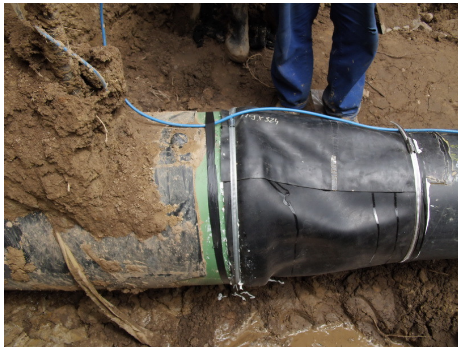
17.kép Gyűrűstér utólagos lezárása, ragasztott gumiharang Forrás: Szűcs László, 2010
