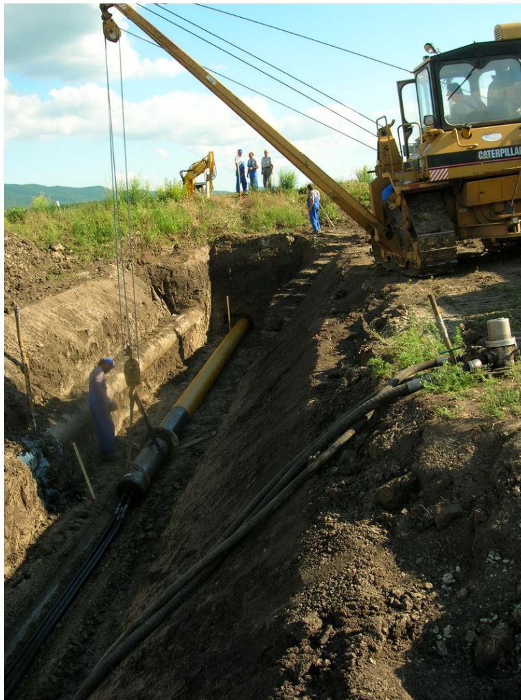
39.kép Újrarendítést megelőző beszerelés Forrás: Szűcs László, 2007
