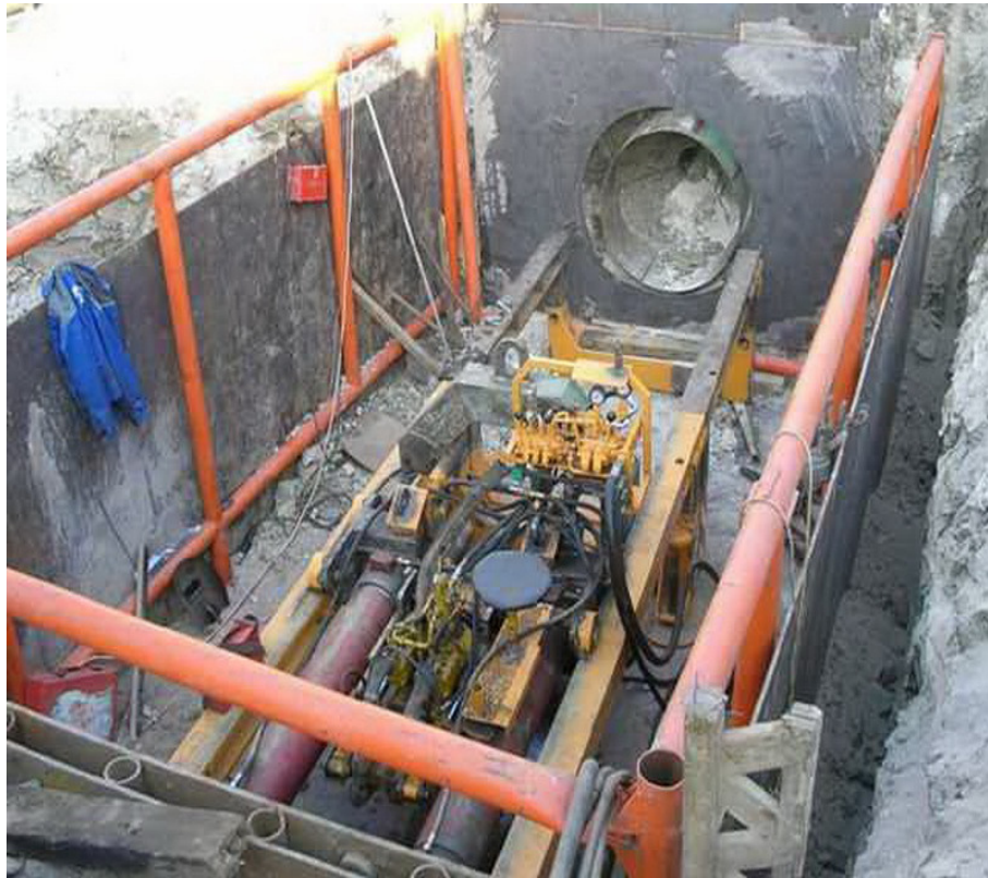
6.kép Hidraulikus sajtoló berendezés
