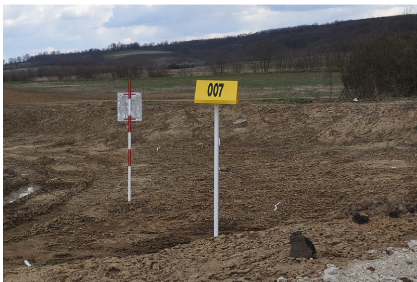
48.kép Nyomvonaljelző és kotrást tiltó tábla Forrás: Dénes Pál, 2015
