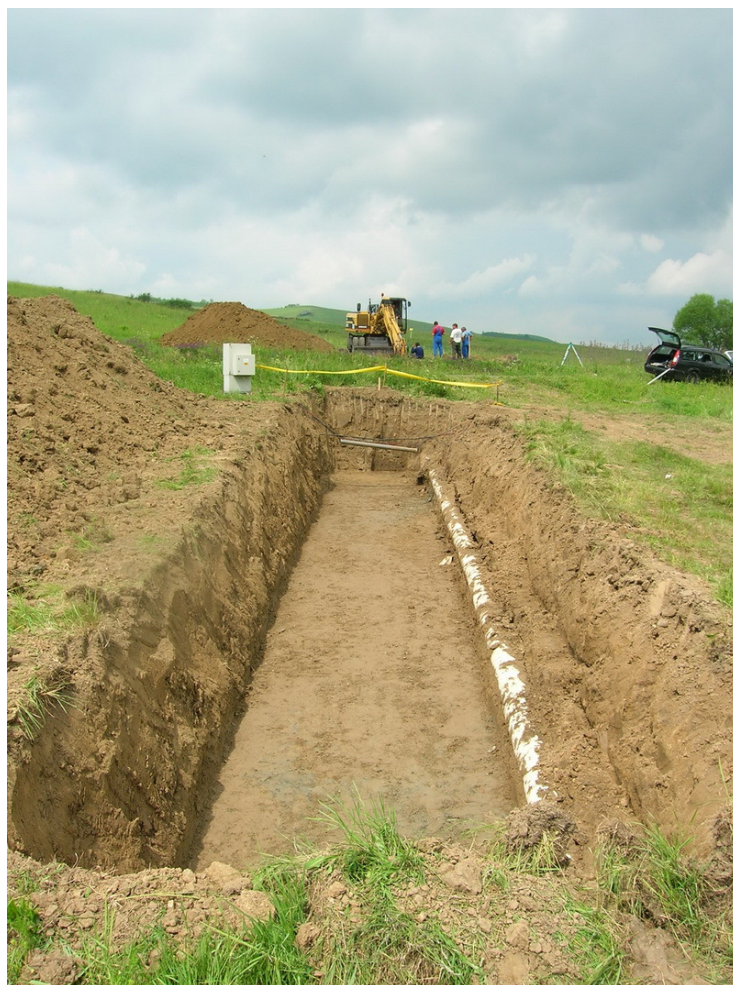
38.kép Szintezett indító árok Forrás: Szűcs László, 2007
