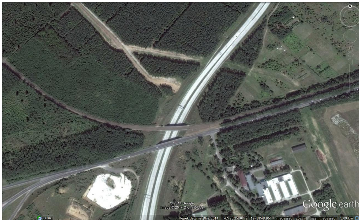
56.kép 2014-es légi felvétel – A műtárgy irányított fúrással már elkészült, látható a frissen takart nyomvonal miatti színeltérés. A Barátság I. nyomvonalától eltérő, attól északra leágazó védelmi övezet a 2013-ban épített DN800 PN75 Szlovák – magyar gázvezeték Forrás: Google Earth
