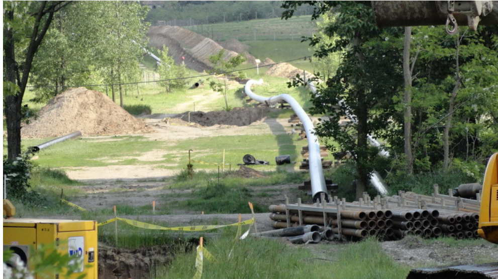
57.kép A behúzendó csőszakasz Forrás: Dénes Pál, 2014
