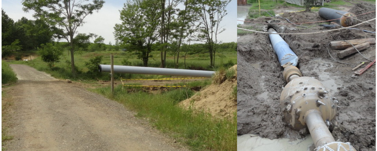
61.kép M31 autópálya, 3-as főút, Gödöllő HÉV sikeres keresztezése, balra a műtárgy déli, jobbra az északi végpontja Forrás: Horváth Gusztáv
