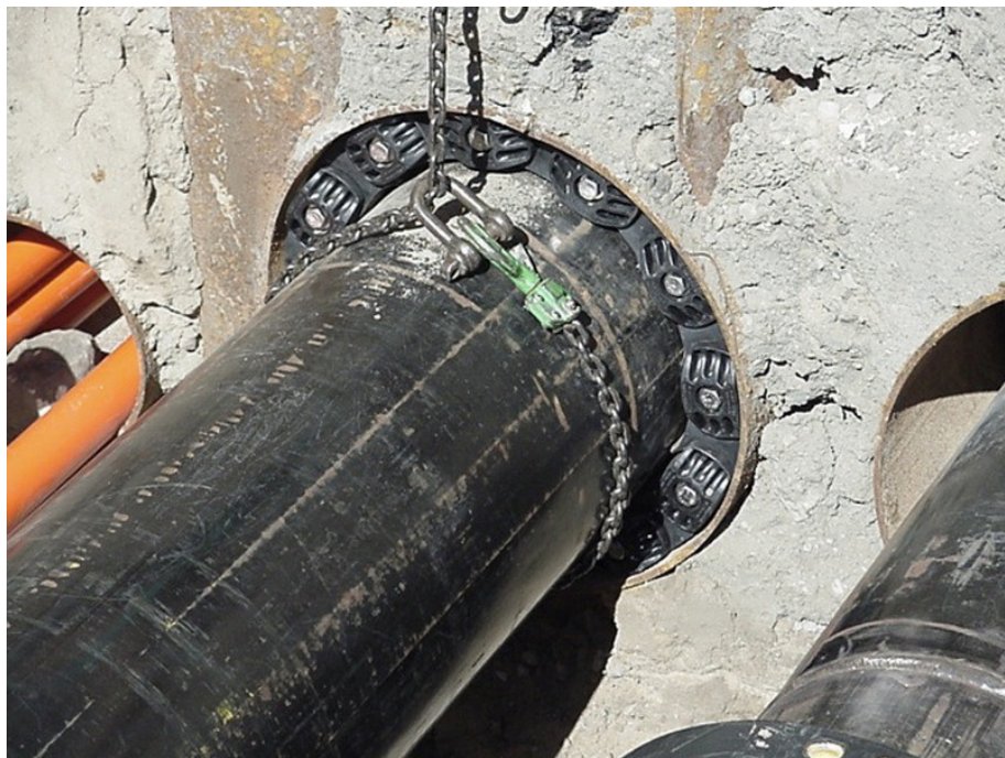
15.kép Központosító elem, linkseal gyártmány Forrás: www.tervan.hu
