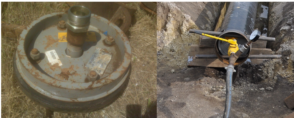
33.kép Végzáró tárcsa, Tracto-Technik Technologies gyártmány DN450 méretben, balra kiszerelt állapotban, jobbra a csővégebe illesztve – elzáróval, nyomásmérővel és 2" levegőtömlővel Forrás bal oldali kép: Szűcs László, 2014 Forrás jobb oldali kép: Horváth Gusztáv, 2014
