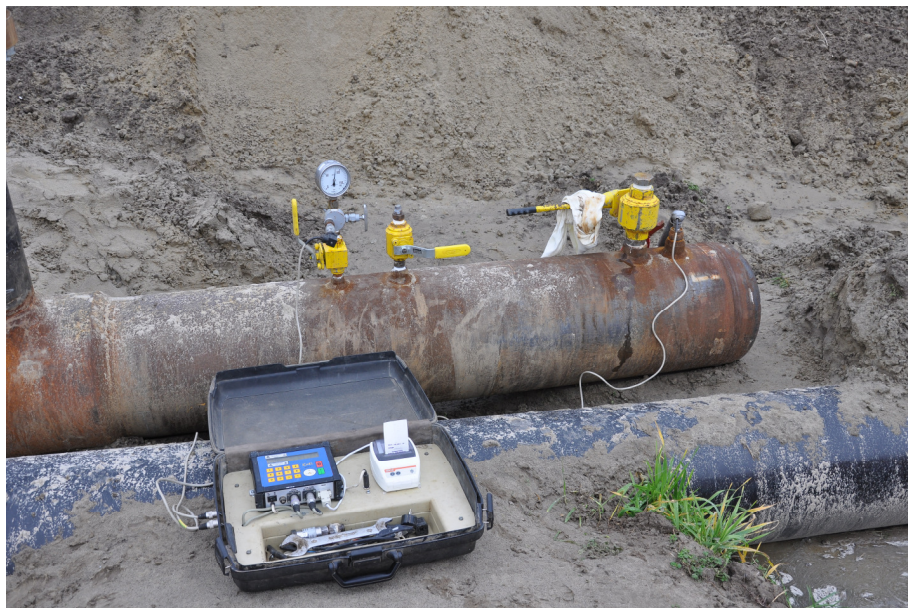
41.kép DN450 nyomóvég szerelvényezett állapotban nyomás alatt, balról: 1/2" csónk gömbcsappal, háromjáratú tűszeleppel abban manométer és PTT távadó, 1" csónk elzáróval a nyomásfokozáshoz, 2" csónk elzáróval a feltöltéshez, M20 x 1,5 csónk a hőmérséklet távadó elhelyezéséhez Forrás: Horváth Gusztáv, 2014
