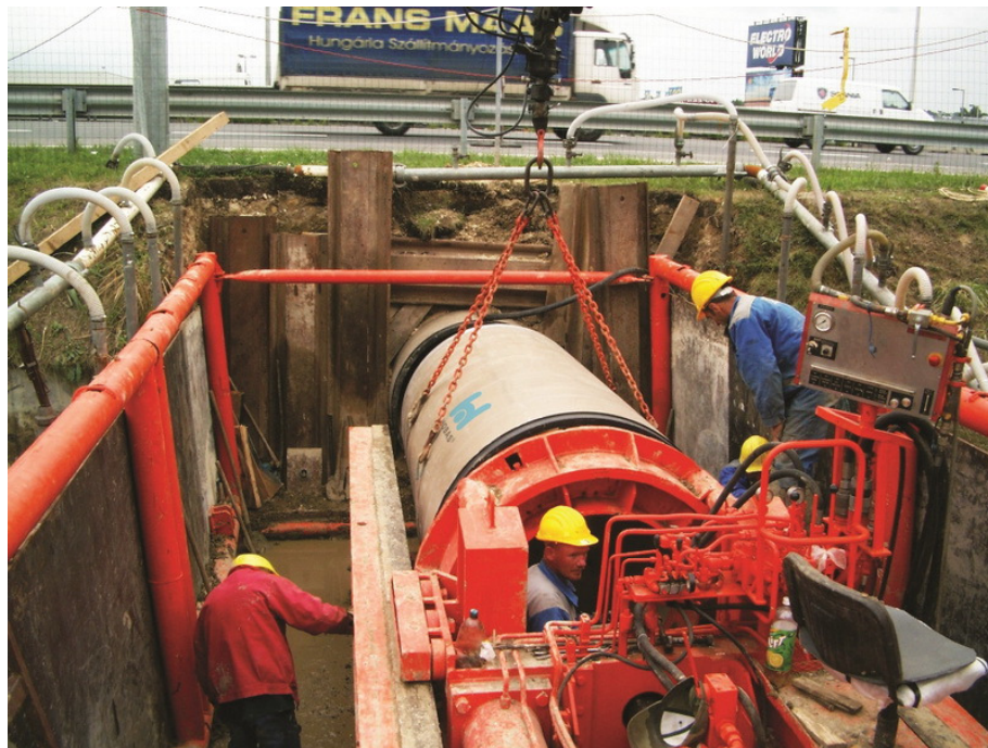
7.kép Sajtoló berendezés indító árka Forrás: www.hobas.hu
