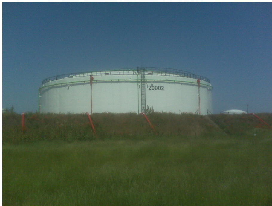
46.kép Állóhengeres tárolótartály, 20.000m 3 névleges térfogat Forrás: Szűcs László, 2015
