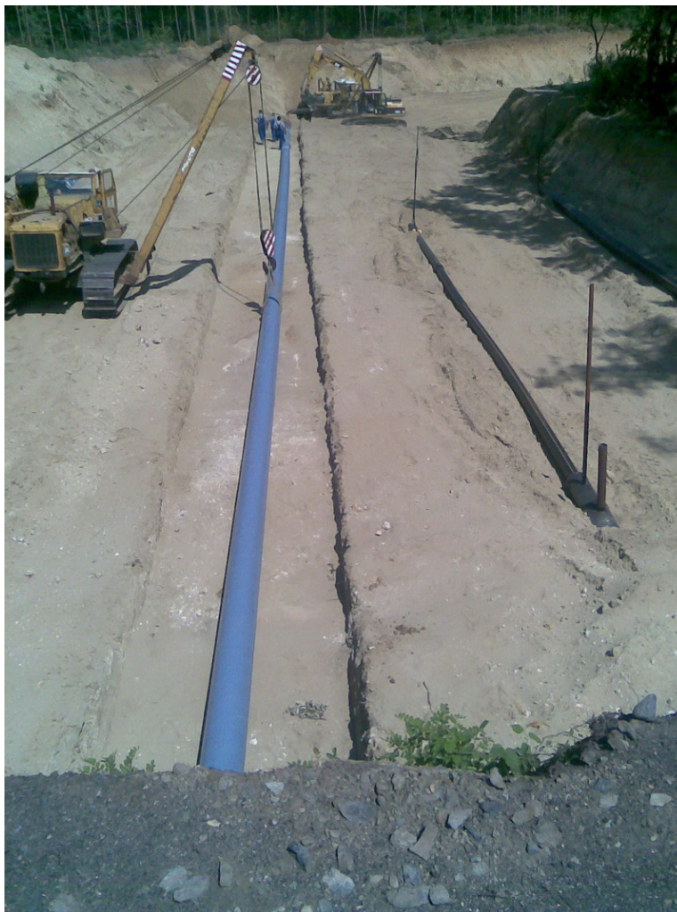
53.kép Indító árok a 3-as számú főút és a Budapest – Gödöllő HÉV alatti sajtolásokhoz – jobbra a már elkészült védőcső végek és PE csövek Forrás: Szűcs László, 2009
