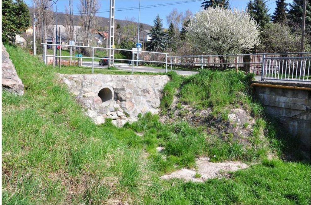
DN25 KPE szennyvíz bevezetés a 0+397,20 fm szelvényben
