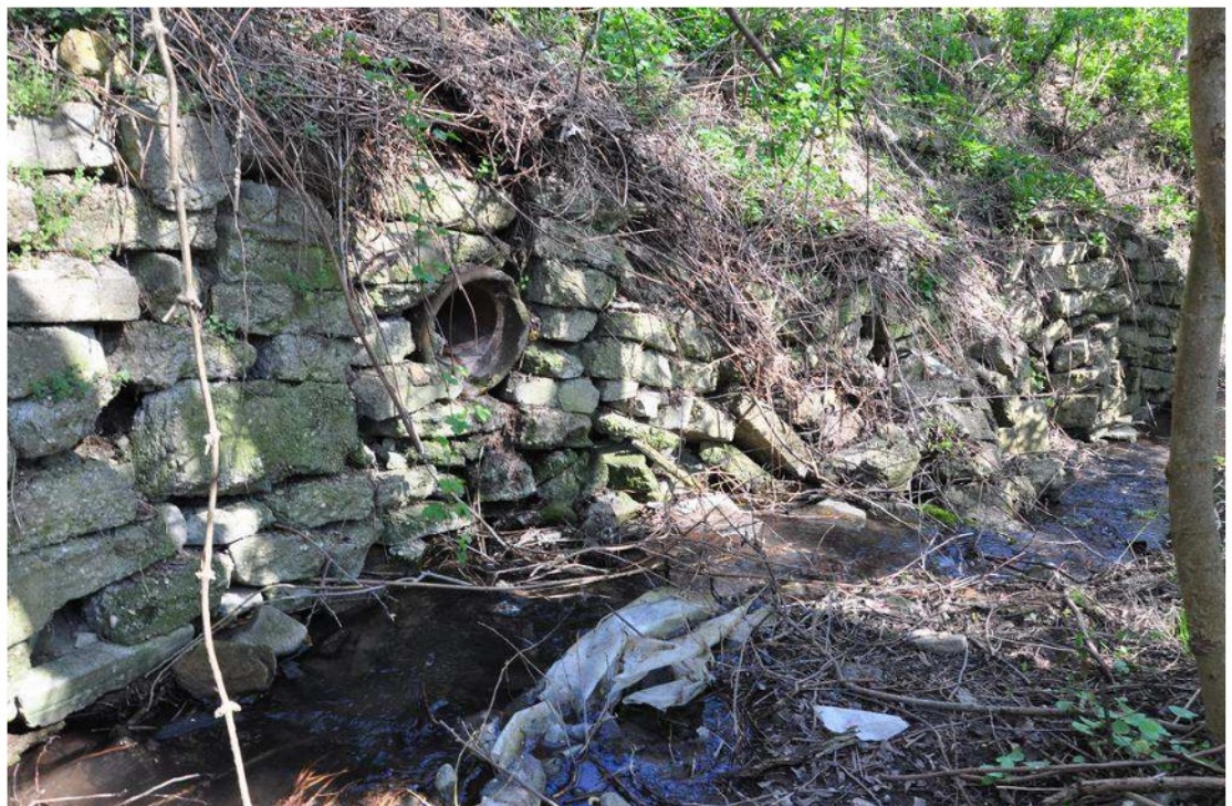
DN 250 szennyvíz bekötés a 0+244,02 fm szelvényben
