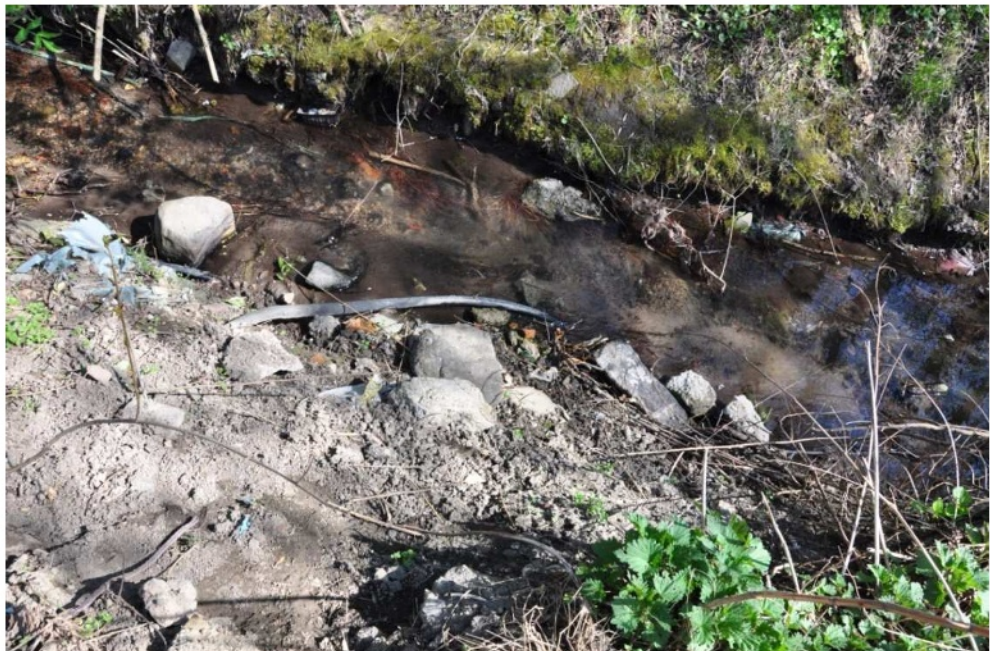
DN25 KPE szennyvíz bevezetés a 0+397,20 fm szelvényben
