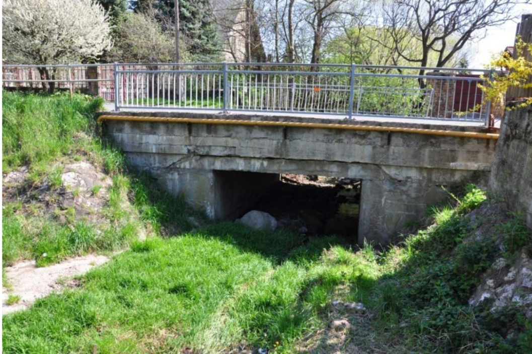
0+291,12 – 0+299,40 fm sz. között közúti híd (Szabadság tér)
