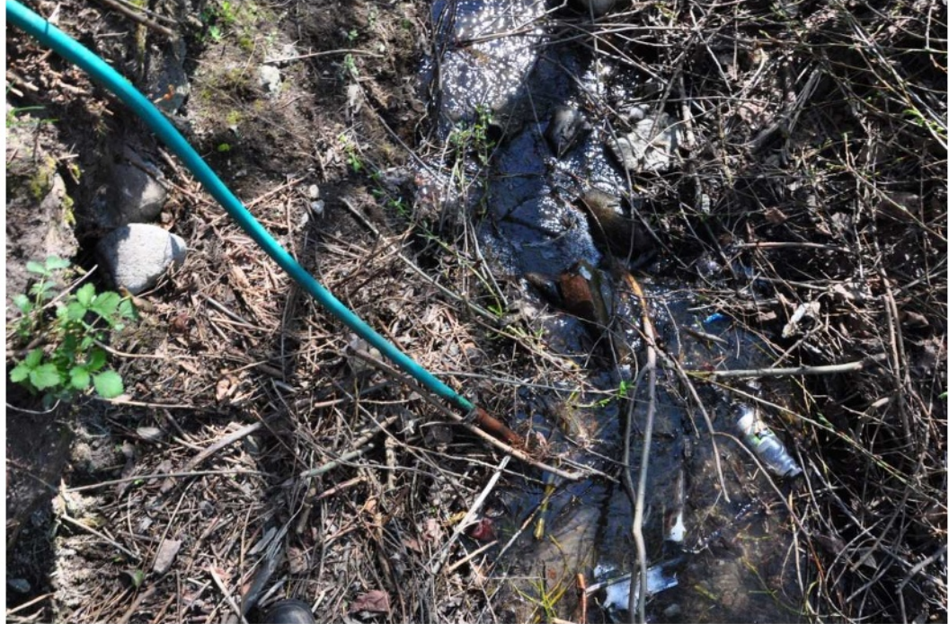
DN100 cső szennyvíz bevezetés a 0+597,30 fm szelvényben
