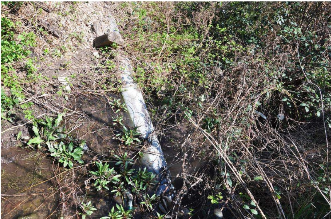
0+333,74 fm sz. – DN 400 szennyvíz csatorna keresztezés
