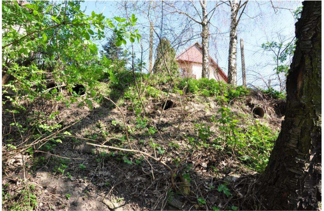
DN 250 szennyvíz bekötés a 0+244,02 fm szelvényben
