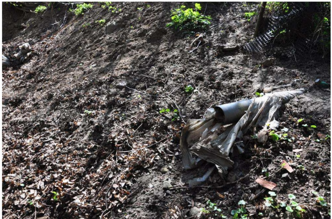
DN100 cső szennyvíz bevezetés a 0+597,30 fm szelvényben
