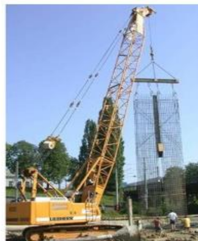
5.ábra: Armatúra beemelése
