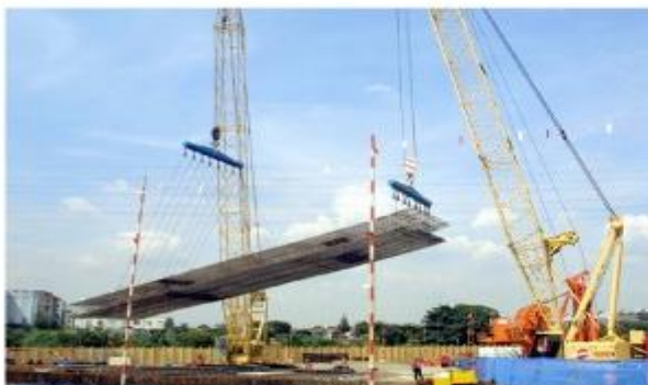
A vasalás beépítése résfalaknál
