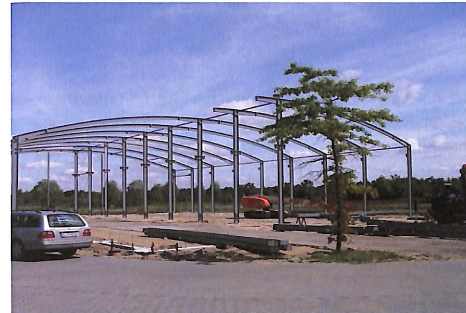
1. ábra Íves csarnokszerkezet
