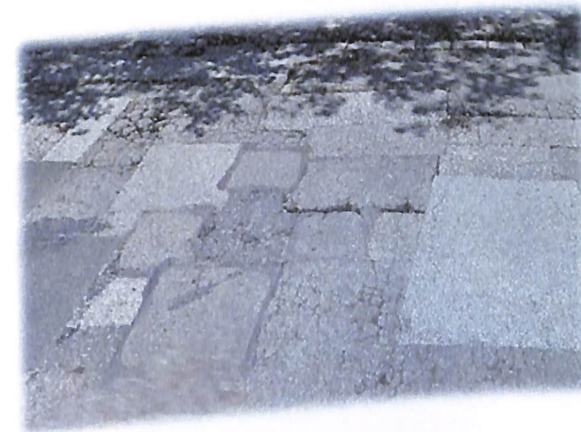
7. ábra Keréknyomvályú és többszörös rájavítások
