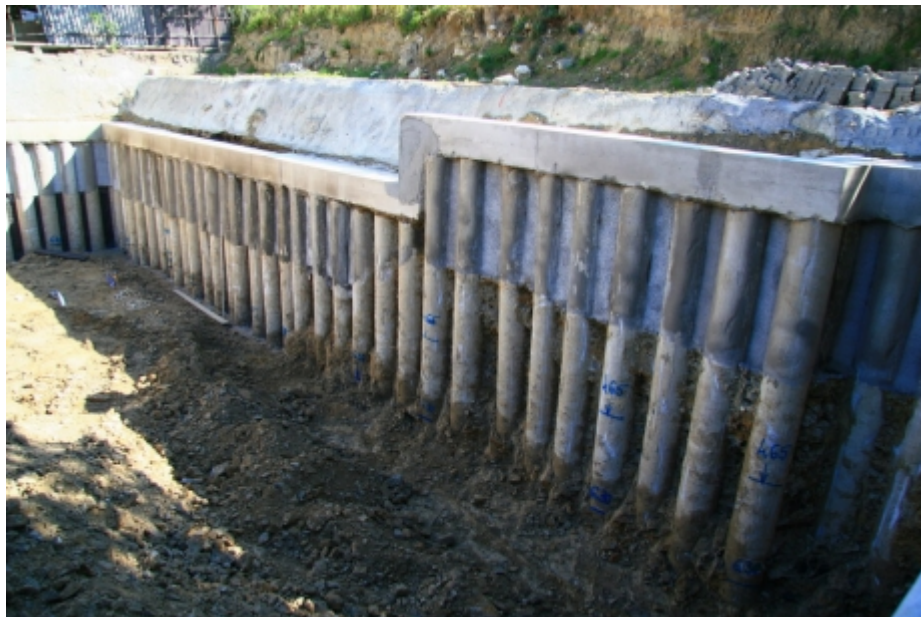
40. ábra: Takarás nélküli hézagos cölöpfal
