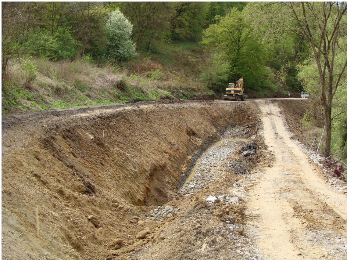
50. ábra: Szivárgóvizek elvezetése az építési időszak alatt
