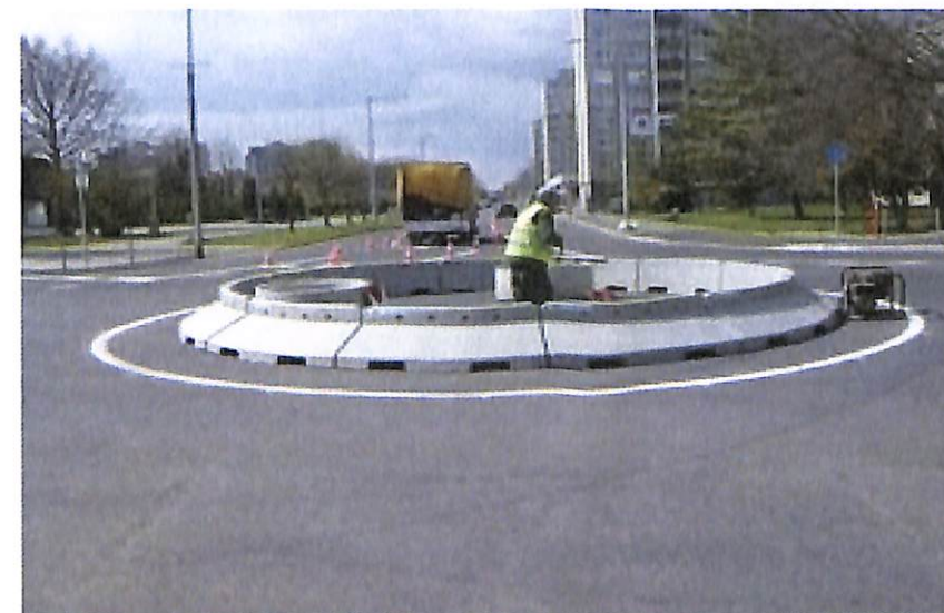
9. kép. Kör szegmensekből álló New Jersey fal középszigetben
