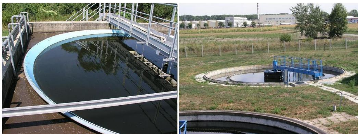
3.3. ábra: Kommunális BCT típusú szennyvíztisztítók 10000 lakosegyenértékig 23
