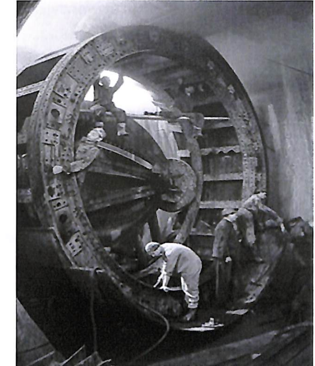
10. ábra: Alagútépítő pajzs a kelet-nyugati metró vonalán 1952-ből
