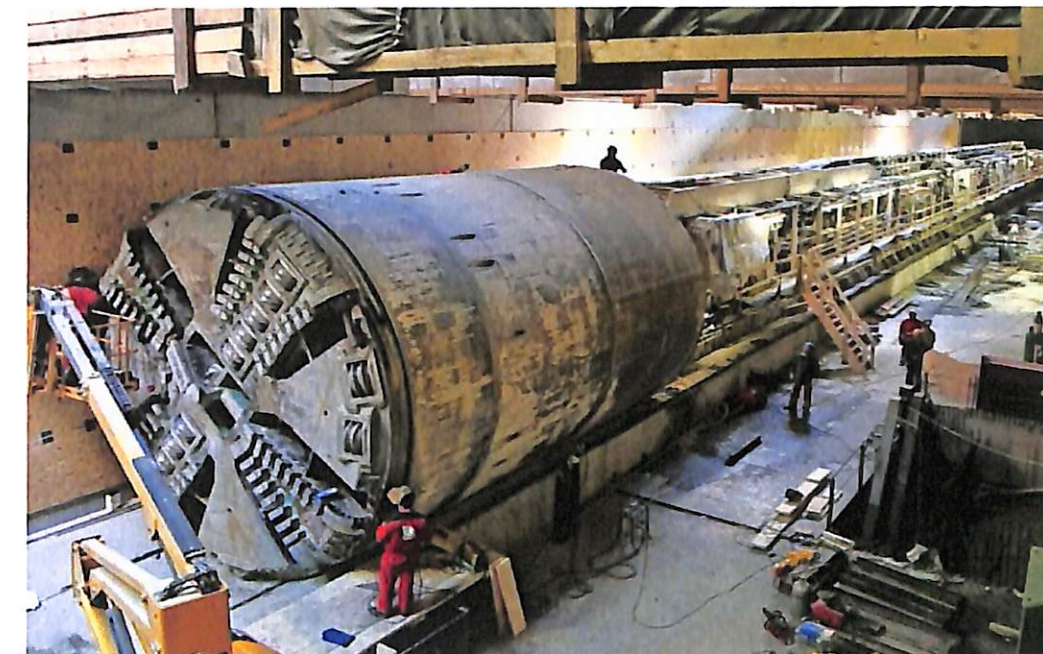
12. ábra: A teljes géplánc együttes hossza 116 m
