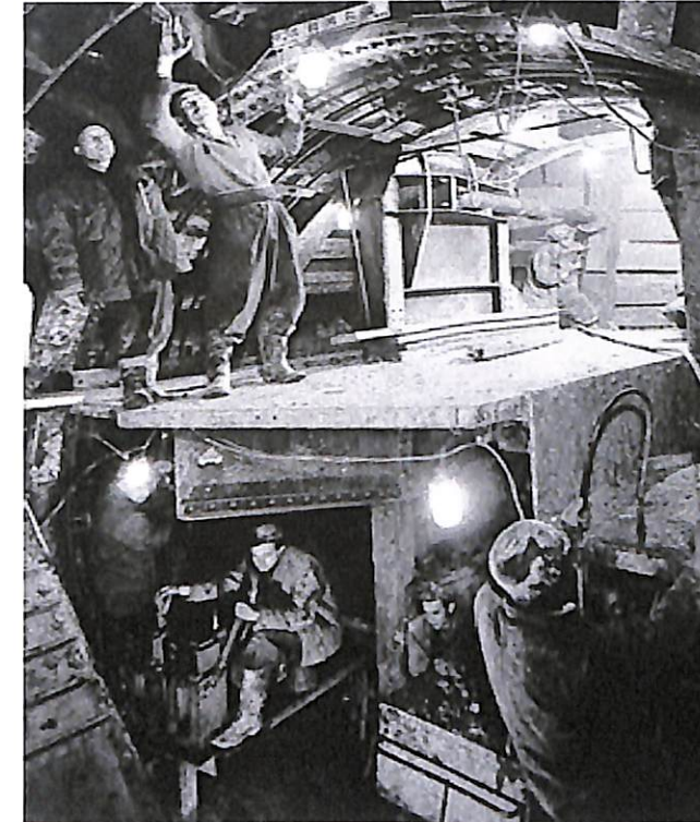
10. ábra: Alagútépítő pajzs a kelet-nyugati metró vonalán 1952-ből
