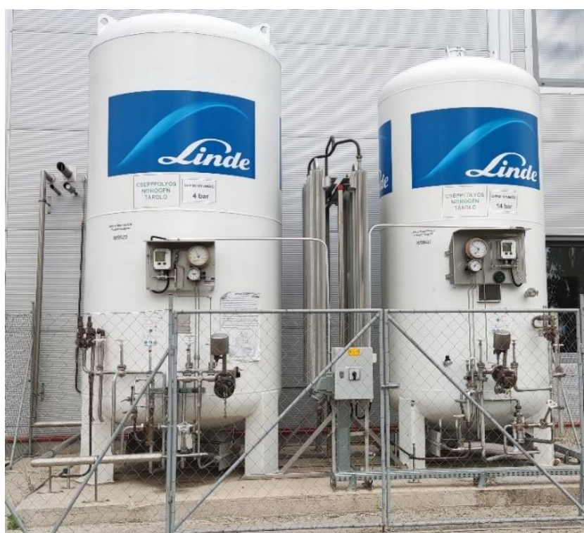
23.ábra. Cseppfolyós nitrogén tárolók a Titán 94 Kft -nél, bal (4 bar) cseppfolyós alkalmazáshoz, jobb (14 bar) gáz halmazállapotú használatra
