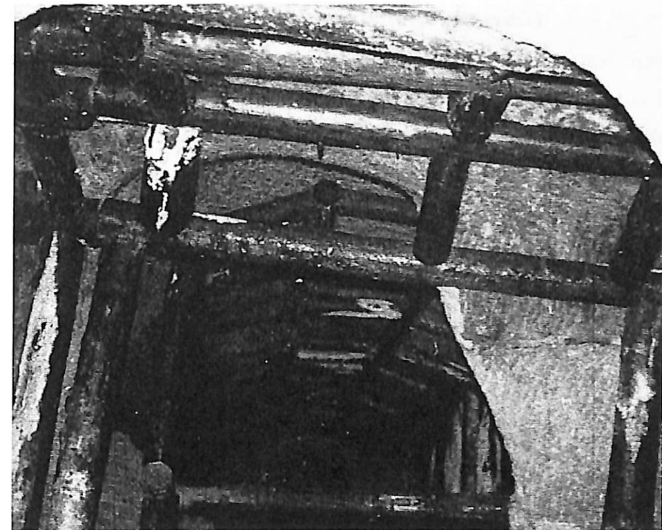
17. kép: Poligonácsolattal biztosított pince. Forrás: [4. p. 329.]
