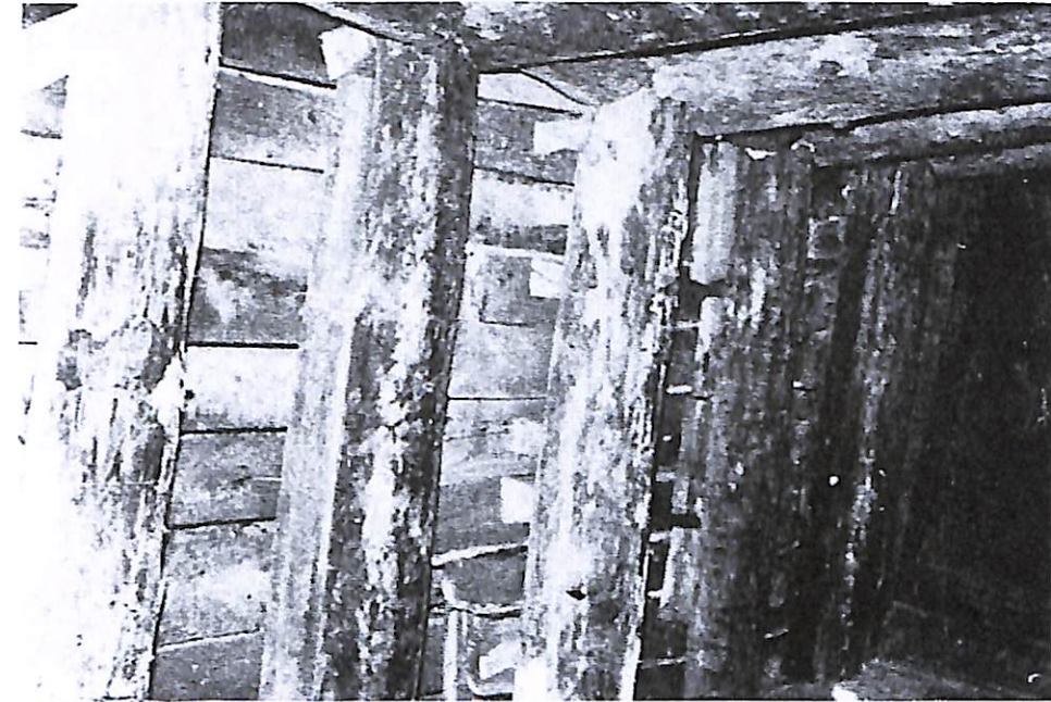
15. kép: Trapézácsolattal biztosított pinceág. Forrás: [4. p. 329.]
