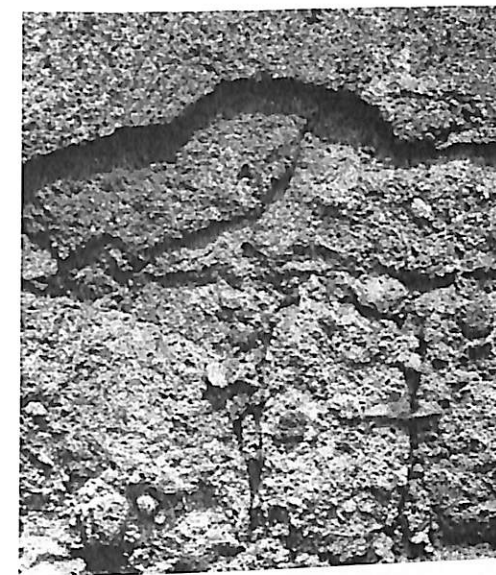
2. kép: Víz hatására a tufa leveti a vakolatot Forrás: [4. p. 255.]
