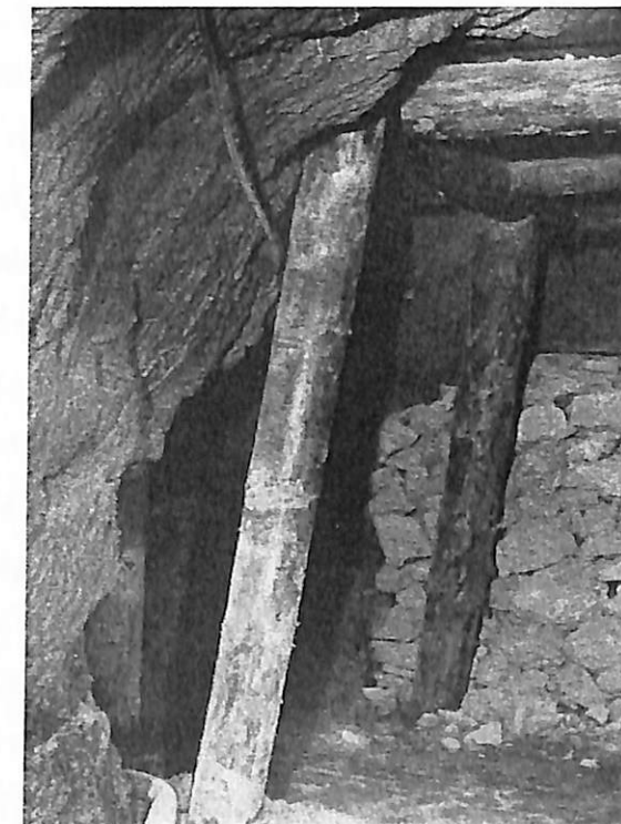
9. kép: Ideiglenesen biztosított pince tömedékelése (1974, Eger.). Forrás: [4. p. 340.]
