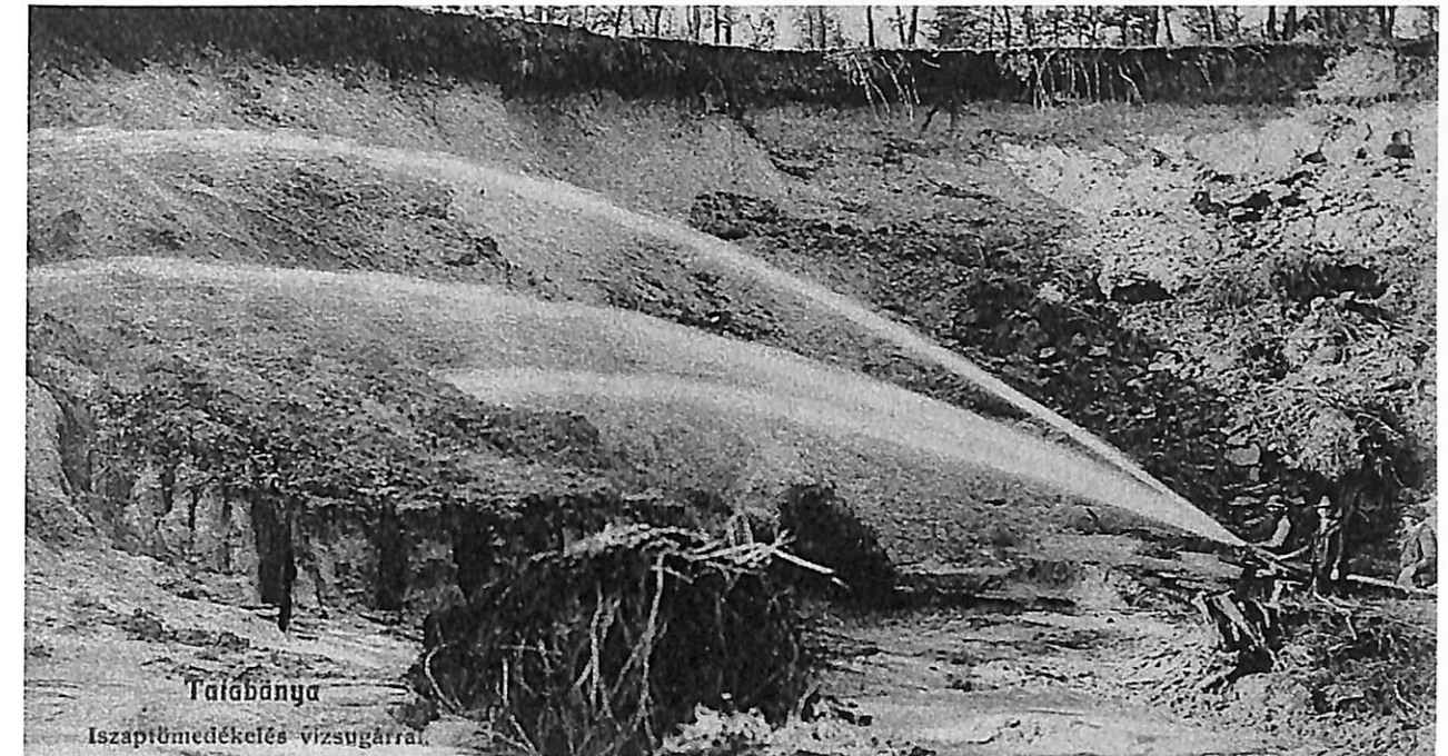
10. kép: Homokjövesztés Tatabányán az iszaptömedékeléshez
