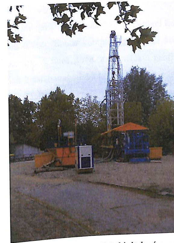
16. ábra Termálkút kivitelezése
