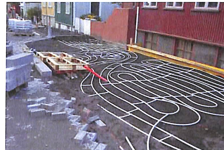
2. ábra Térfűtés építés közben Reykjavikban
