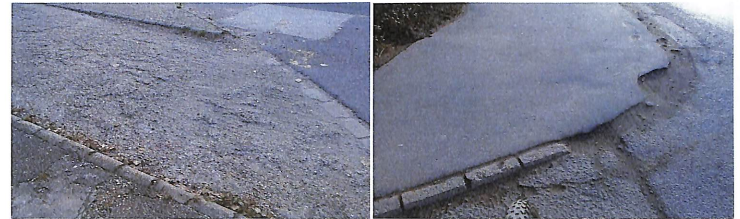
34-35. kép: Fel-lehajtó rámpa és sérült, roncsolódott járdaszegély
