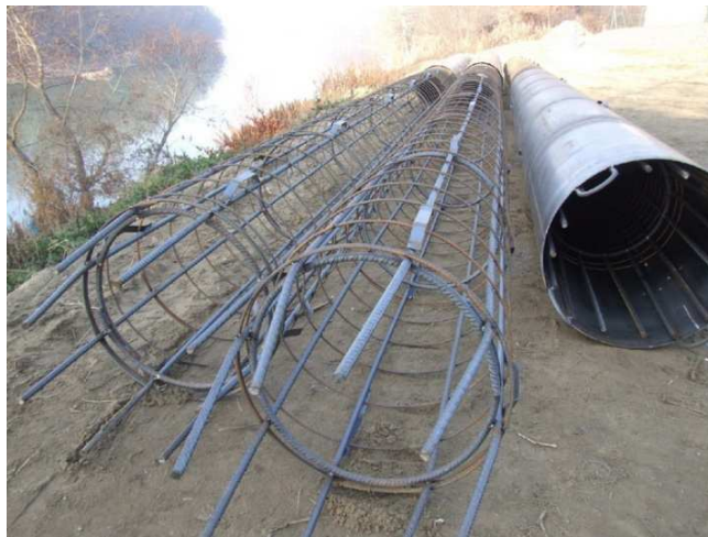
8. ábra: A megszerelt, beemelésre váró cölöp armatúra
