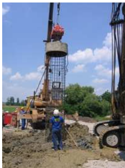
9. ábra: Armatúra elhelyezése vibrálással
