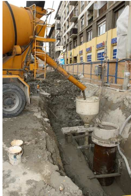
12. ábra: A rés kitöltése betonnal, a résiszap folyamatos szivattyúzásával
