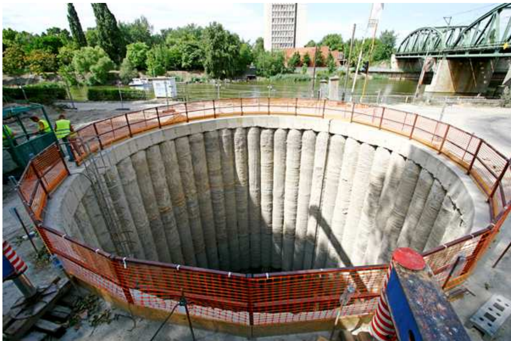
4. ábra: Cölöpfalas munkatérhatárolás - vízzáró, összemetsző kivitelben
