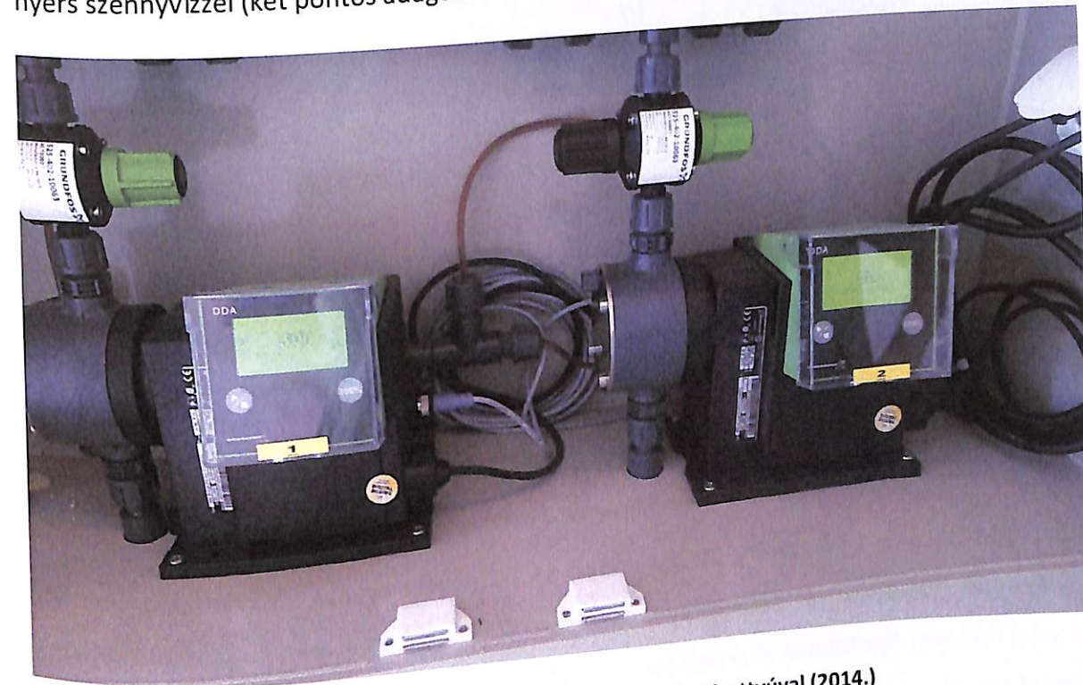
13. Kép: Vegyszeradagoló panel membrán szivattyúval (2014.)
