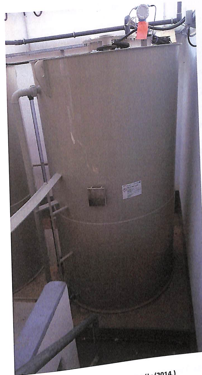
12. Kép: Vegyszeradagoló tartály (2014.)
