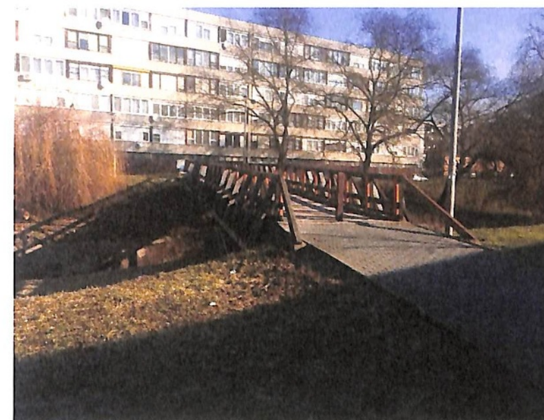
1. Meglévő faszerkezetes híd
