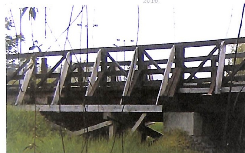
5. Dúcolás és kitámasztások megerősítése
