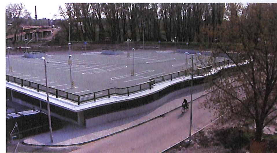
55. kép: Vasbeton szerkezetű parkolólemez (Győr)
