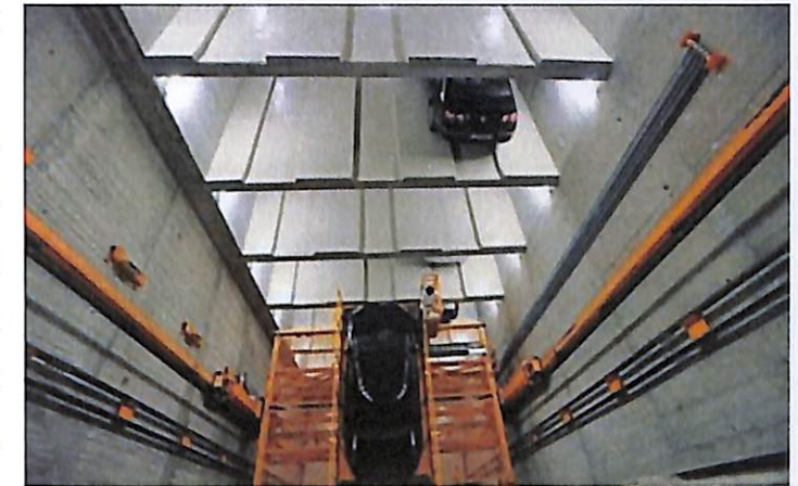
61. kép: Automata mélygarázs működése
