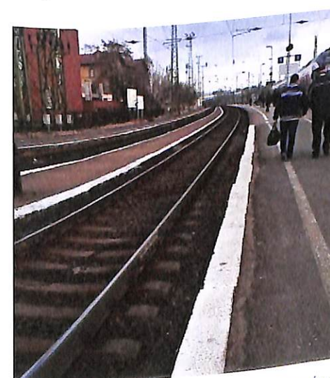
54. ábra Nagyvasúti vágány - Ferencváros MÁV állomás
