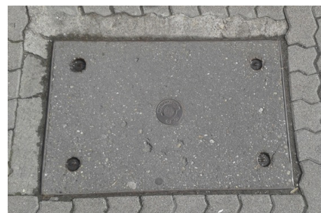
23. kép: Távközlési, elektromos aknafedlap és minta betonból
