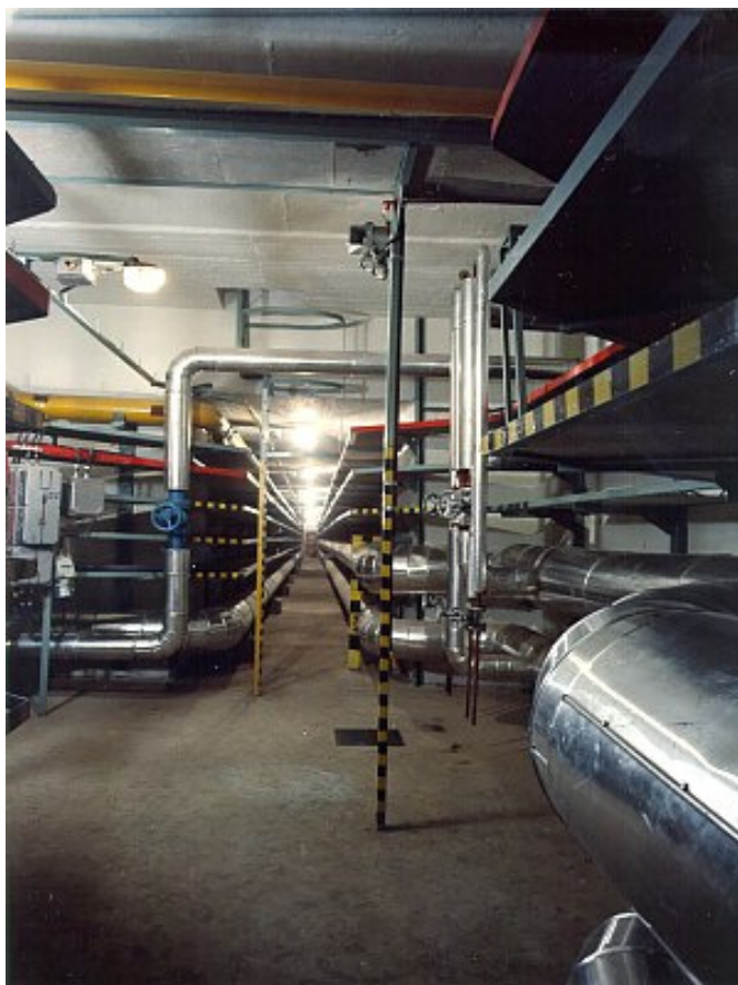
16. kép: Pesterzsébeti közműalagút belső tere
