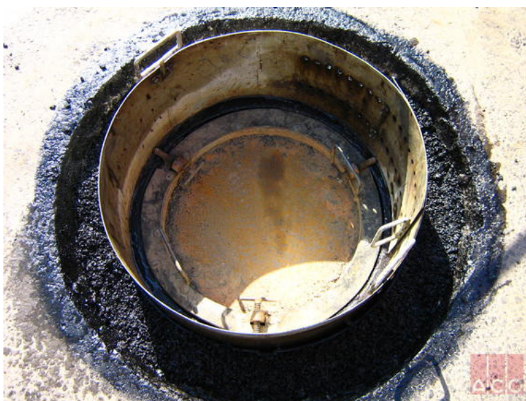
47. kép: ACO fedlap csere, nyaktag javítás 1
