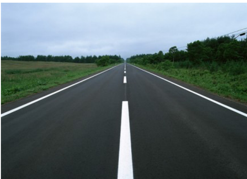
30. kép: Gumibeton felületű út Jánoshida és Jászboldogháza között
