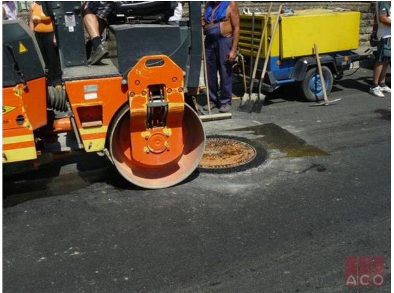
48. kép: ACO fedlap csere, nyaktag javítás 2
