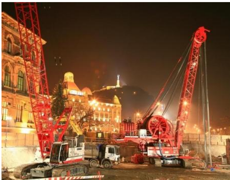
7. ábra: Épülő résfal a négyes metró Szent Gellért téri megállójánál
