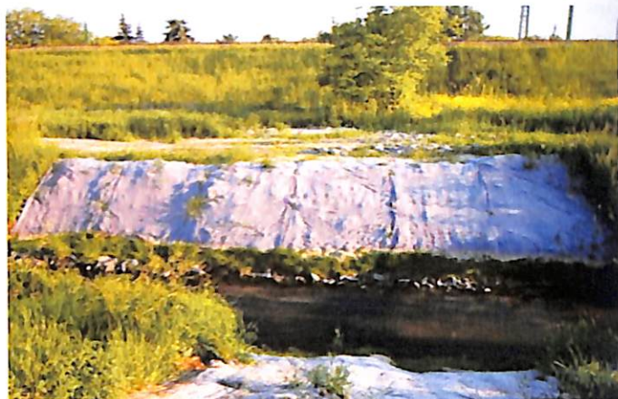
Erózióvédelem geotextiliával
