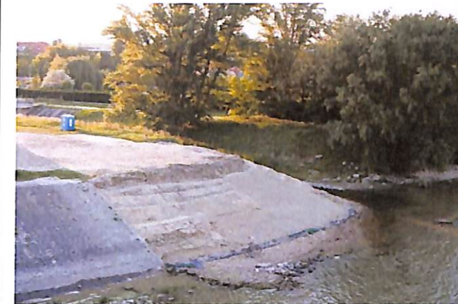
A pata torkolata az Újpesti vasúti hídról fényképezve
