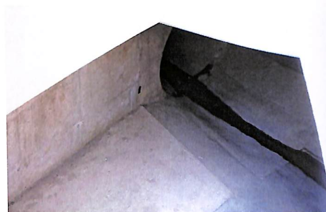
Csapadécsatorna bekötés a híd alatt
