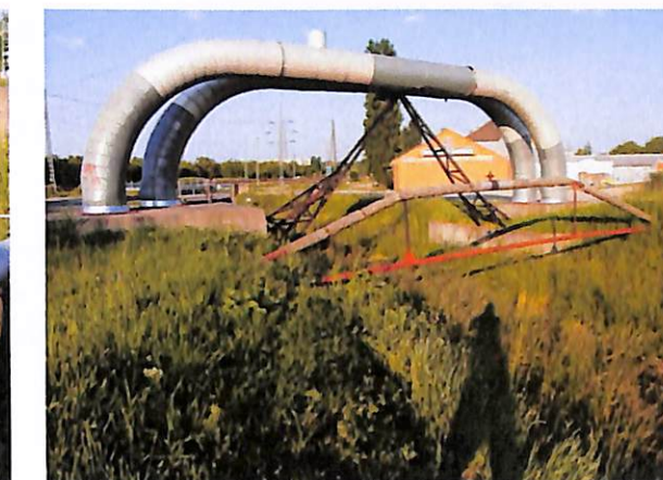
NÁ 1000 táv hő csőátvezetés NÁ 250 csőátvezetés.
