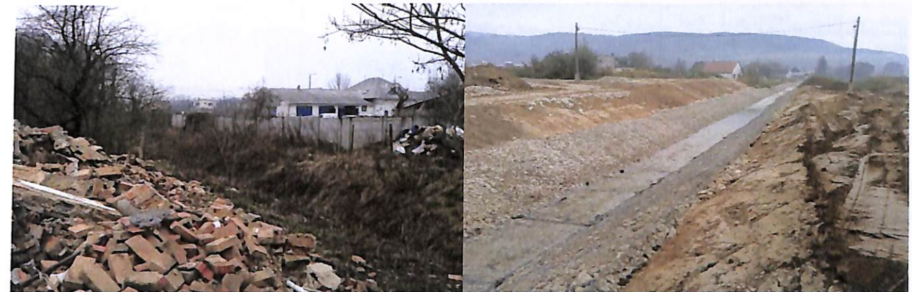
Az Aranyhegyi-patak egyik mederkorrekciója (fent a régi állapot, lent az új mederkialakítás RENO matraccal) Forrás: innorail.hu
