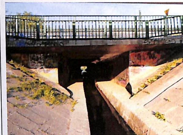
Szentendrei úti közúti és HÉV híd
