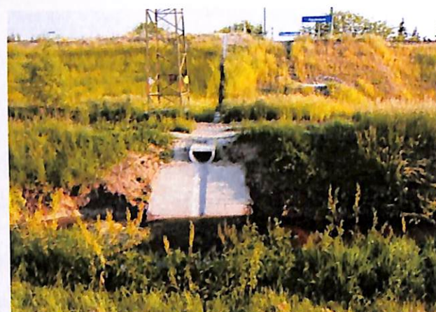
Csapadéksatorna bekötés a környező vasúti földműve árkaiból
