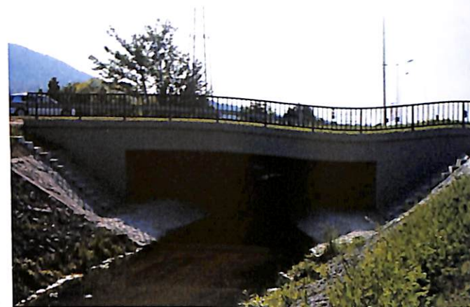
Bécsi úti közúti híd
