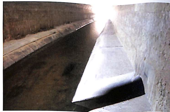
Csapadéksatorna bekötés a HÉV híd alatt
