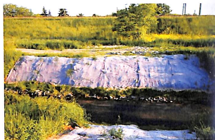
Erózióvédelem geotextiliával
