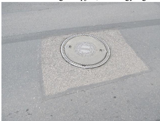
9. kép Akna-fedlap körüli javított aszfalt
