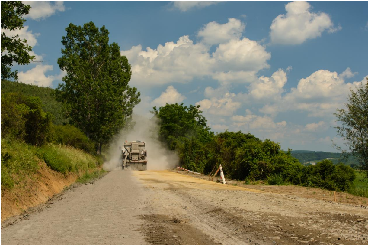
5. kép – cement kötőanyag adagolása
