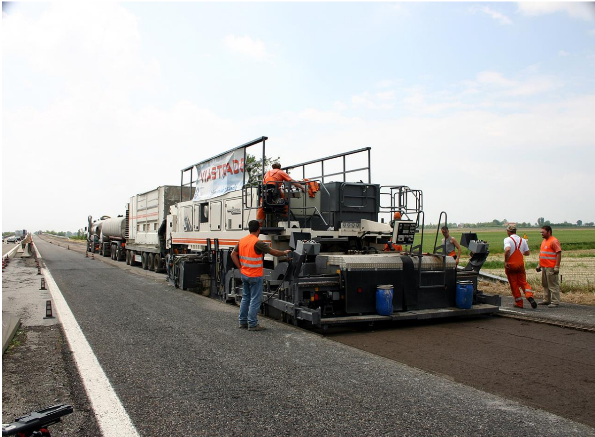
1. kép – kényszerkeverő működés közben
