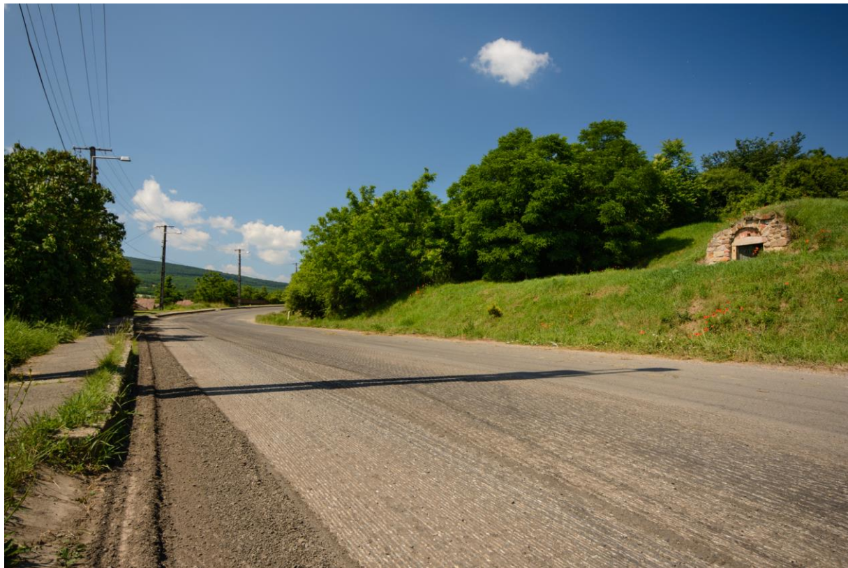
4. kép – a burkolat felülete profilmarást követően
