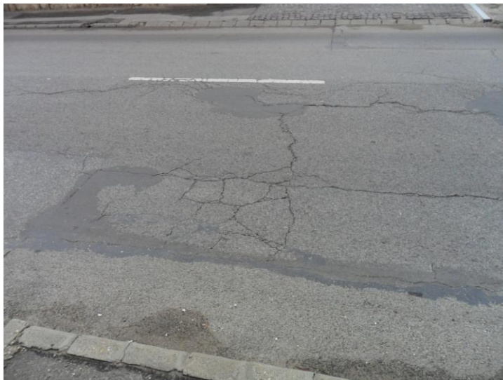
24. ábra Budai u. / Hálós repedés
