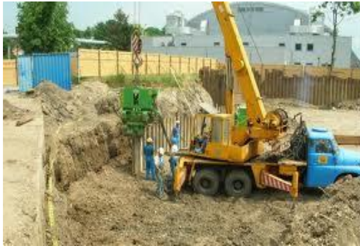
9. Kép: Szádpalló talaj történő lejuttatása
