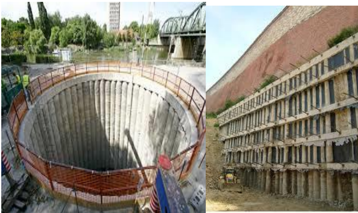
7. Kép: Cölöpfal építési technológiák
