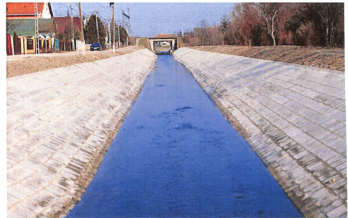
2.számú kép – Burkolt medrű Benta patak belterületi szakasza –
