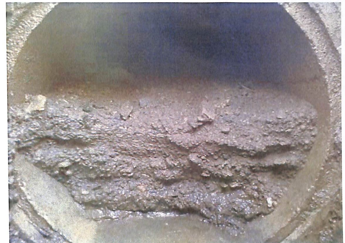
34.számú kép – Eliszapolódott átérész -
