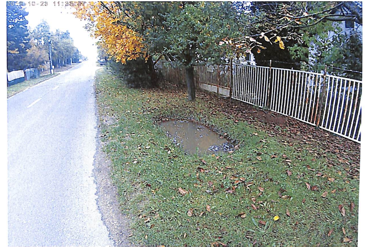
6.számú kép - Szikkasztóként üzemelő földmedrű árok -
