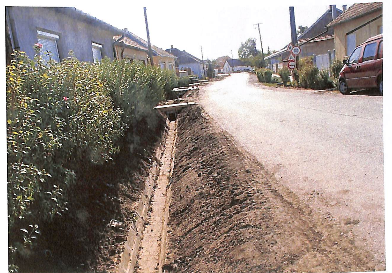
27.számú kép – Beépített árokcső -
