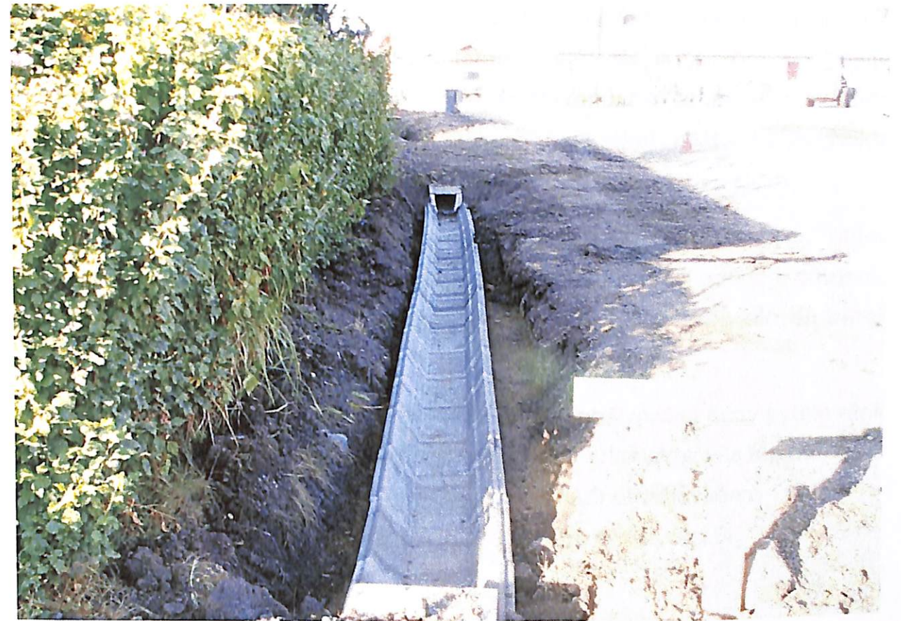
26.számú kép – Beépített árokcső -
