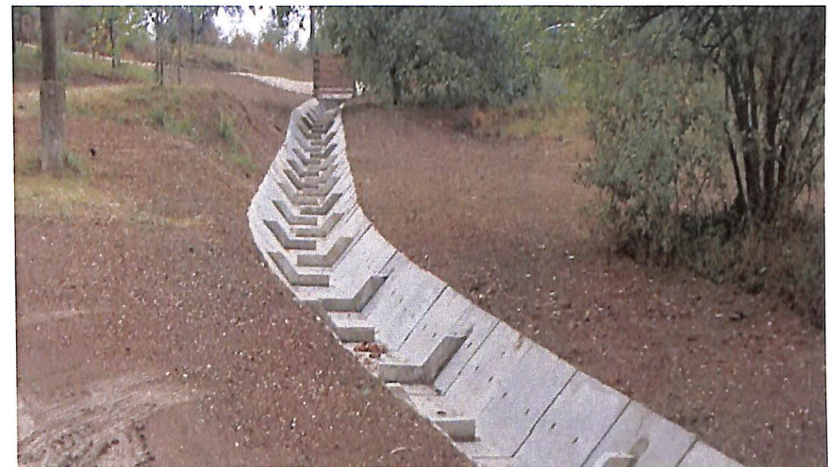
8.számú kép – Energiatörővel ellátott elemek alkalmazása dombvidéki területen -
