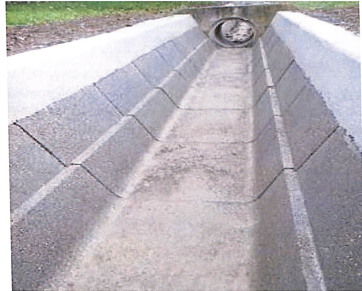
11.számú kép - Árokelemmel burkolt nyílt földmedrű árok -
