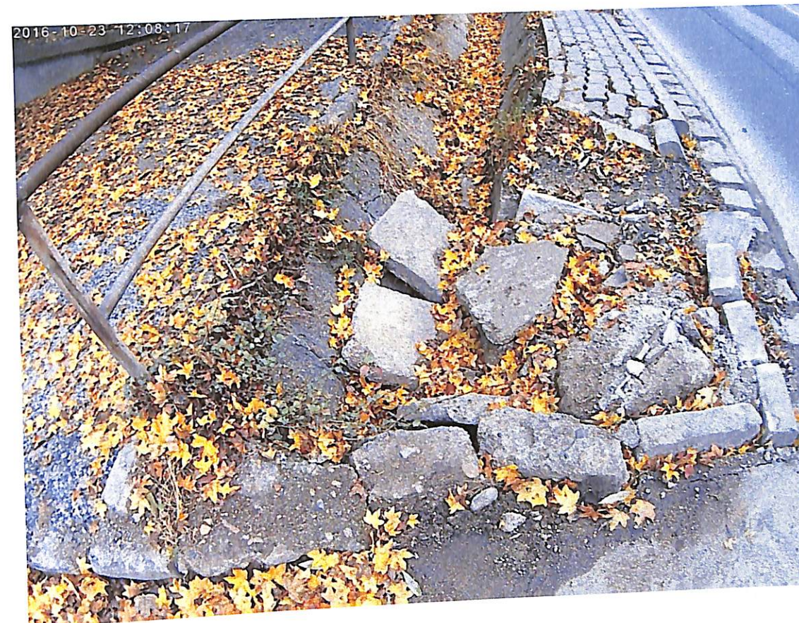
4.számú kép - Bedőlt burkoló elemek -
