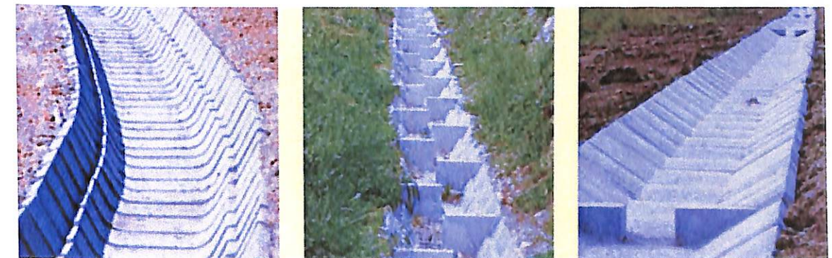
16.számú kép – Árokburkoló elemek alkalmazása –
