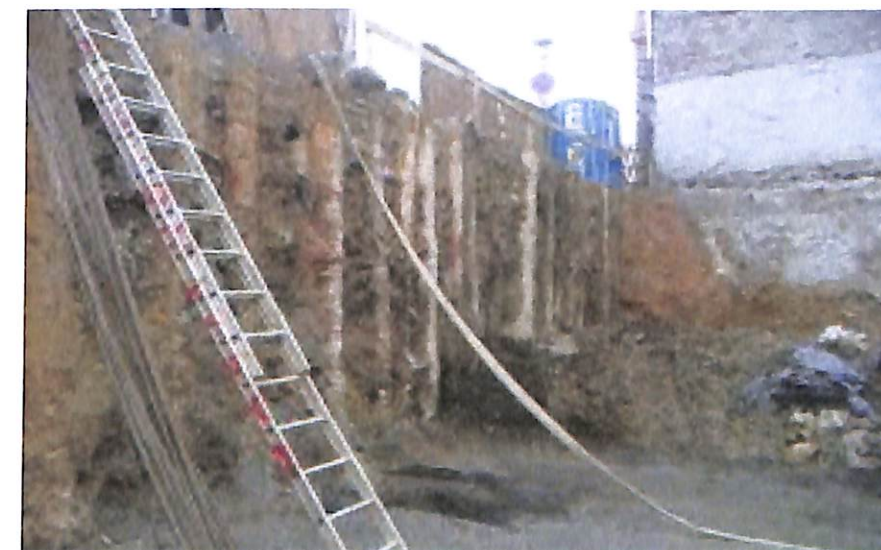
8. kép szádpallók beépítve
