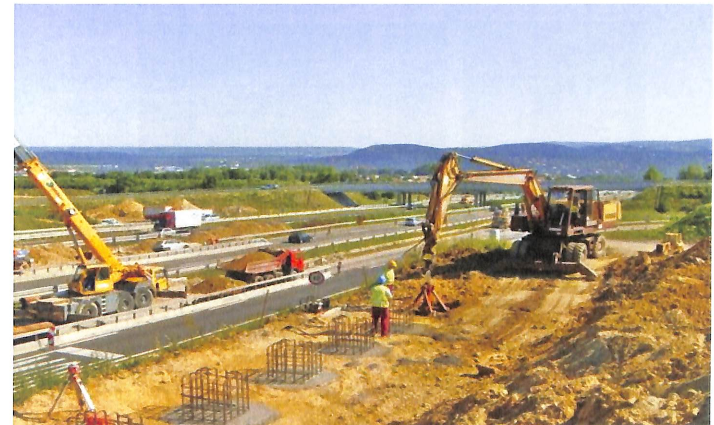
11. kép M7 cölöptámfal
