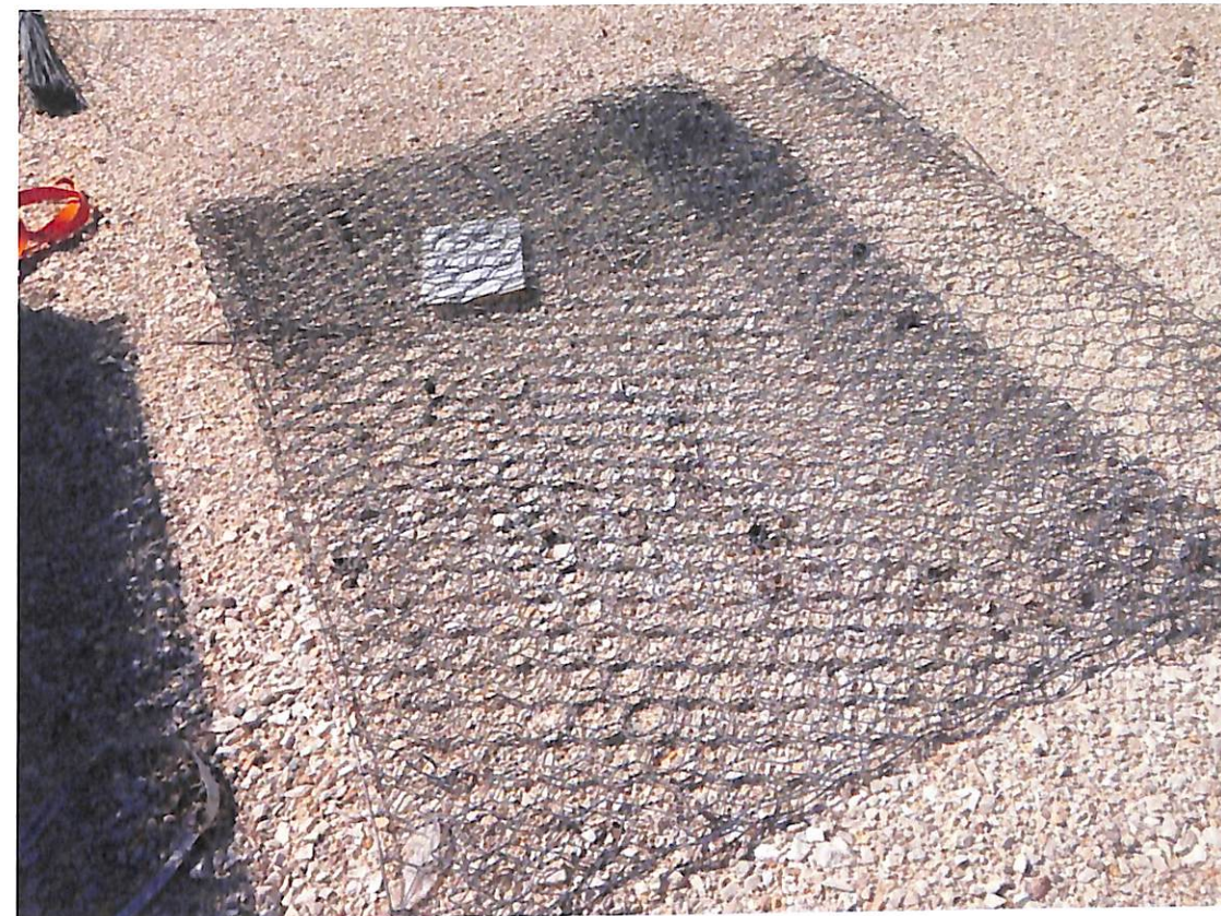
3.kép sodort hálós gabion
