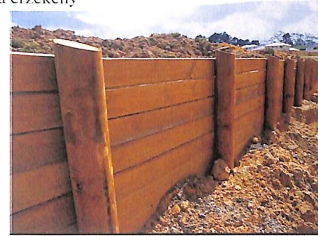
22. ábra - pallóval erősített földterasz
