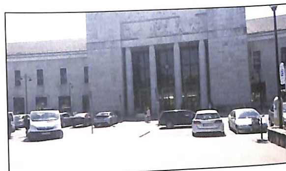
6. kép: Az állomás főépülete, előtte a parkoló
