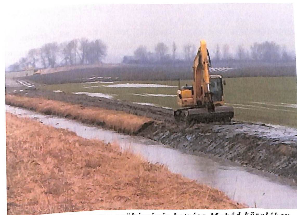
3. kép III. főcsatorna gyökérzónás kotrása Makád közelében
