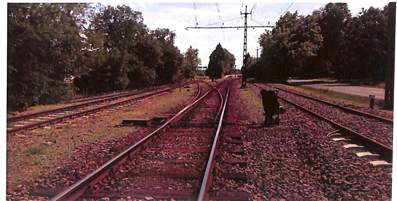
2. kép: Váltókörszet, végpont felől nézve.
