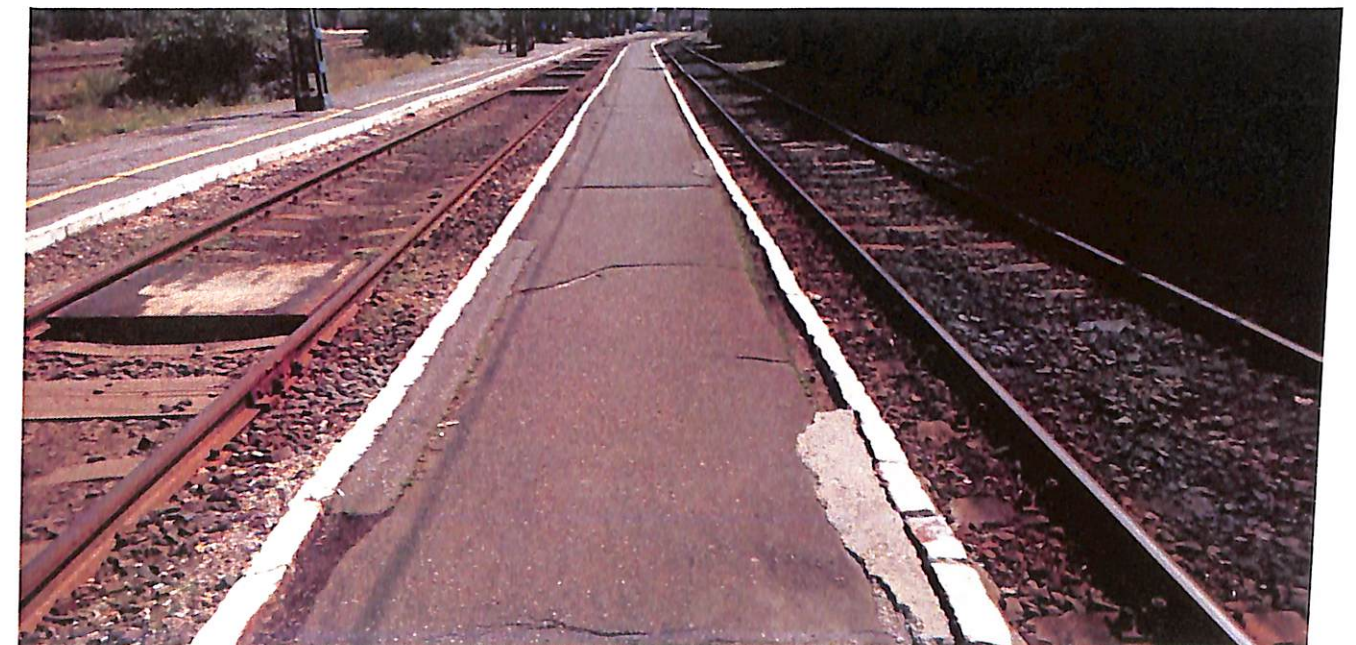
5. kép: Peron a kezdőpont felől nézve.
