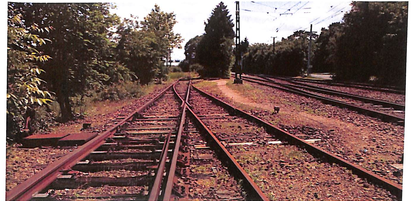
3. kép: Csatlakozó vágány nagyvasúthoz.
