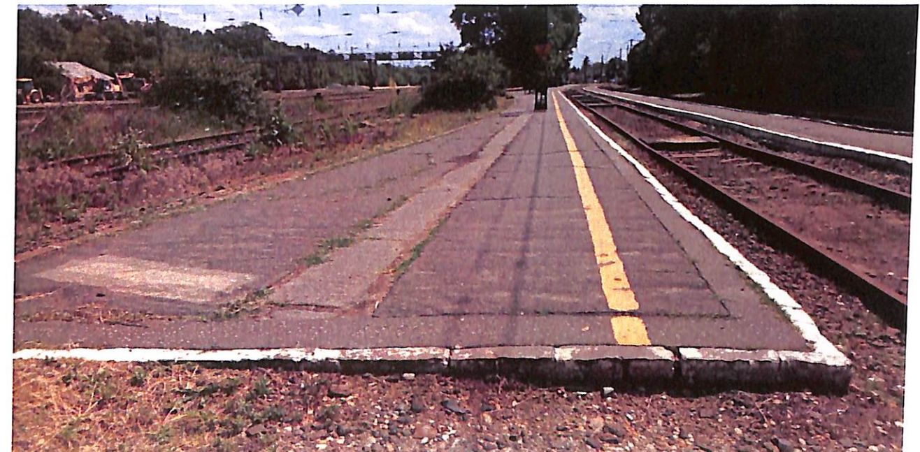
9. kép: Bal peron kezdőpont felől nézve.
