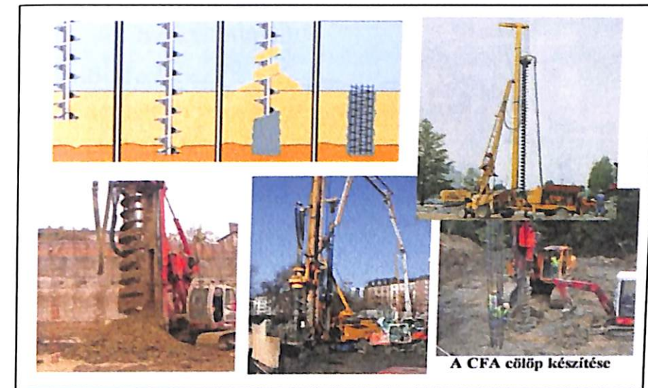
6.1 ábra: A CFA cölöp készítése
